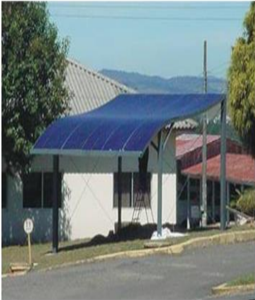
Figura 7 – Módulos solares fotovoltaicos do tipo flexível, colados diretamente sobre superfícies curvas de cobertura metálica em forma de onda. Projeto LABSOLAR/CELESC instalou três sistemas como o da figura em Florianópolis, Lages e Tubarão – SC, com 1.4kWp cada.
