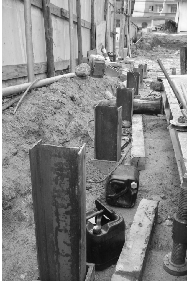
Figura 3.3: Perfis metálicos cravados - Metropolitan Home Boutique – Florianópolis. Adaptado do trabalho da estudante Fernanda Orben de Souza.
