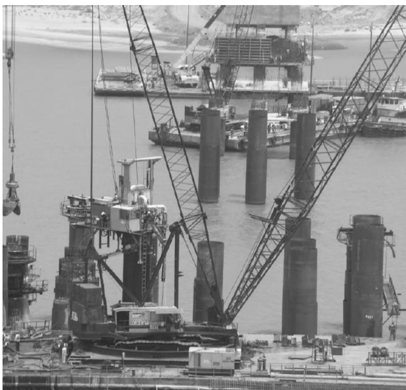
Figura 3.9: Fundação em tubos metálicos para sustentação da ponte sobre o rio Orinoco - Bolívar - Venezuela (Construído pela Construtora Figueiredo Ferraz – Consultoria e Engenharia de projeto LTDA).
