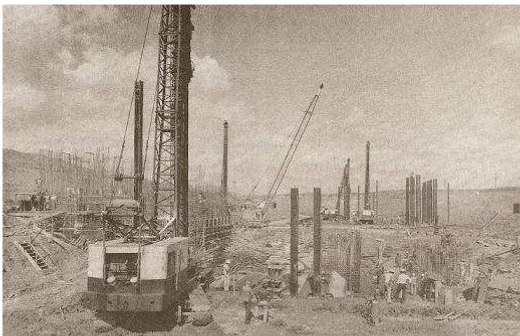
Figura 3.1: Vista geral de um estaqueamento metálico (AÇOMINAS, 1981)
