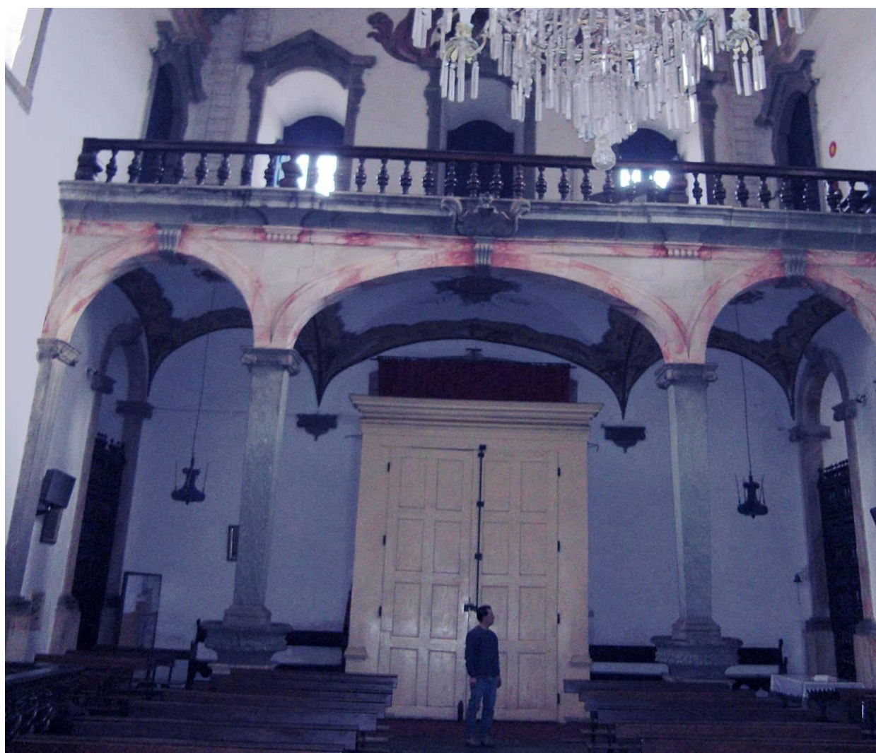
Figura 2.14 - Igreja Matriz Nossa Senhora do Bonsucesso em Caeté-MG: pilares que sustentam o coro, na entrada na nave, construídos em xisto verde sobre base de quartzito. Fotografia capturada em junho-2010.
