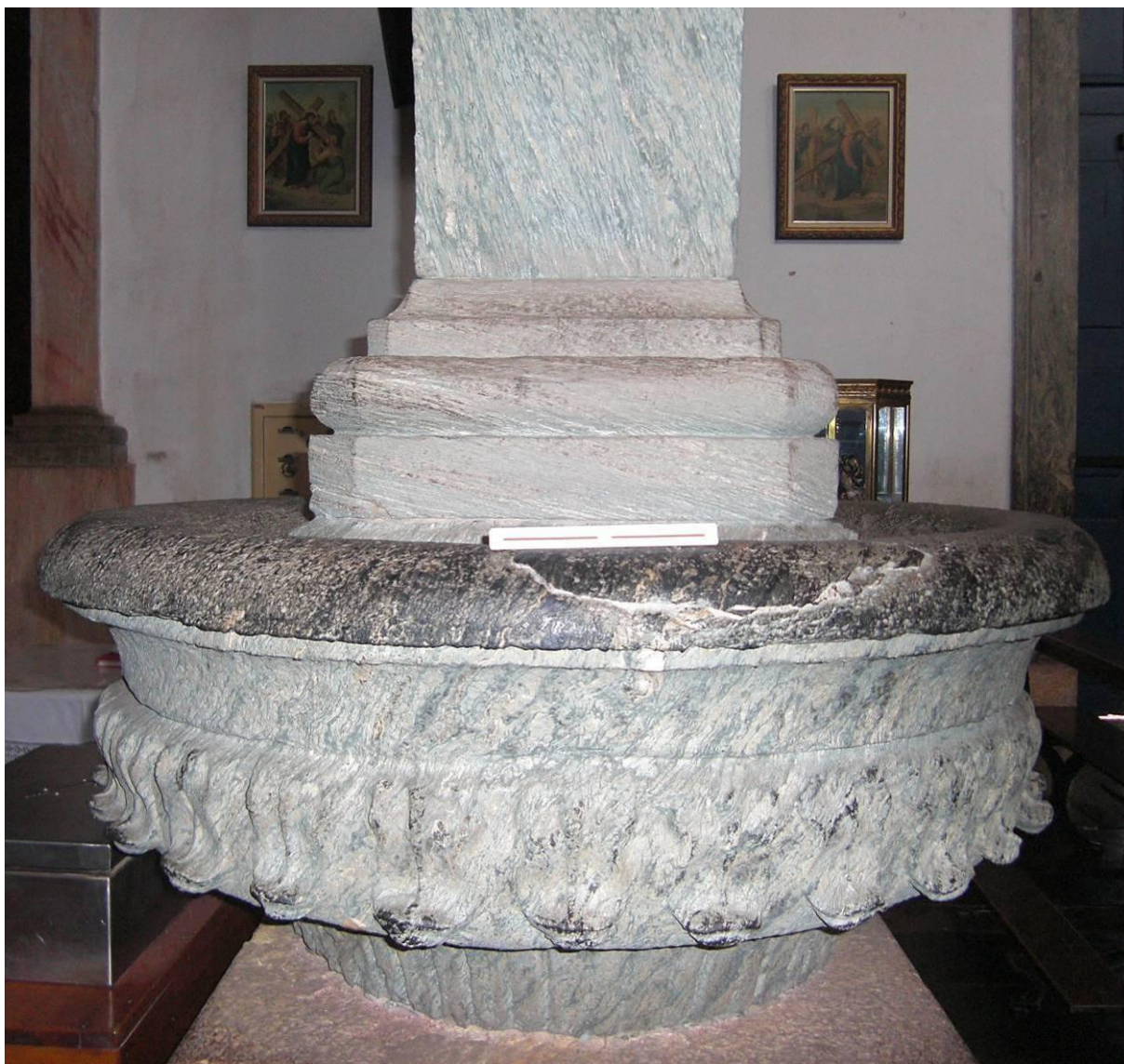
Figura 2.15 - Igreja Matriz Nossa Senhora do Bonsucesso em Caeté-MG: pilares que sustentam o coro, com pia de água-benta ao centro. O escalímetro usado na fotografia tem 15 cm de comprimento. Fotografia capturada em junho-2010.
