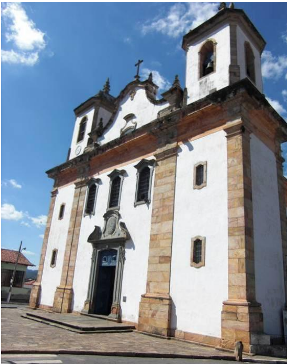
Figura 2.10 - Igreja Matriz Nossa Senhora do Bonsucesso, em Caeté-MG: vista da fachada principal. Fotografia capturada em junho-2010.
