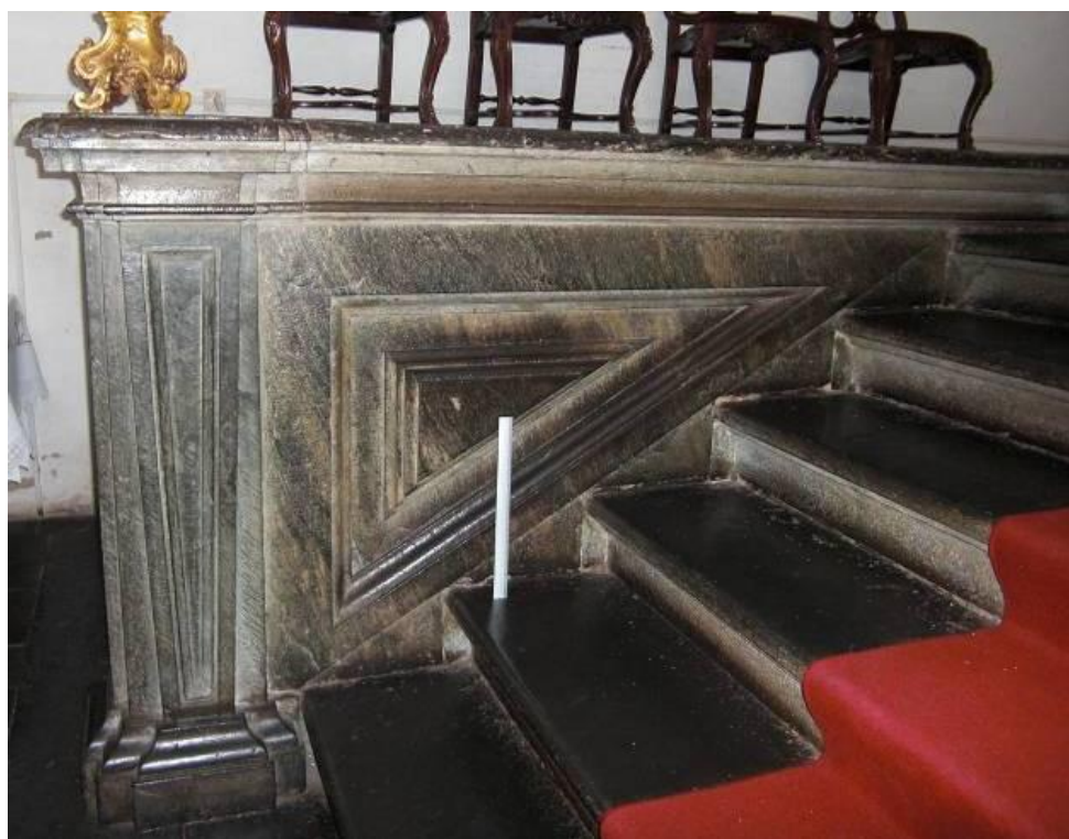
Figura 2.17 – Igreja Matriz Nossa Senhora do Bonsucesso, Caeté, MG: escada de acesso ao altar-mor, com (a) frente e (b) lateral executadas sem emendas, em xisto com bandamento definido pela alternância de bandas quartzo-cloríticos e bandas carbonáticas. Fotografia capturada em junho-2010.
