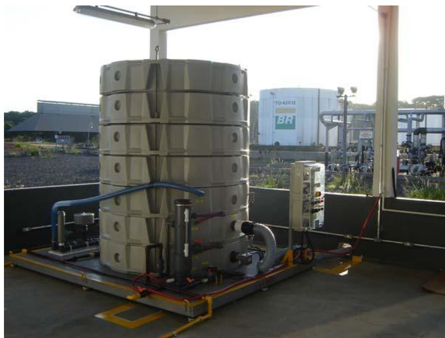
Figura 5 – Biofiltro pré-fabricado. Fonte: www.pruner.com.br .
