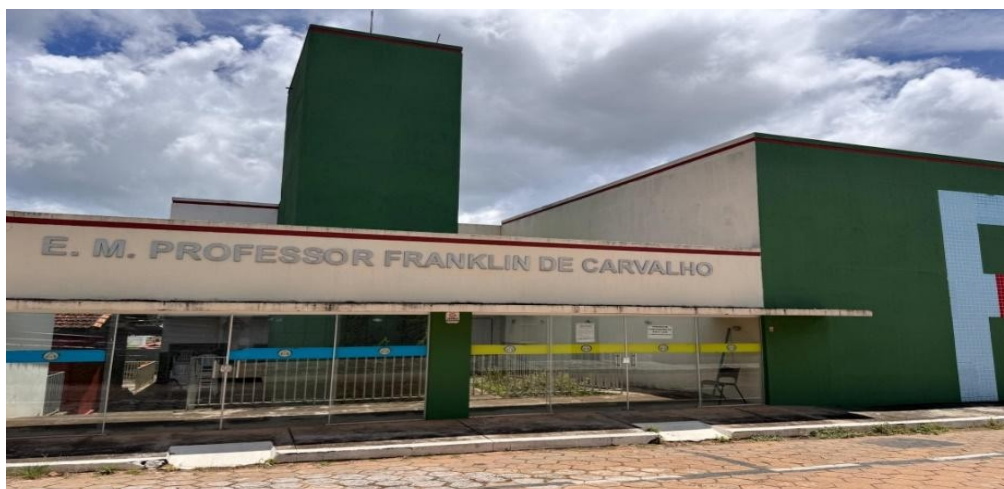
Figura 2- Fachada parcial da Escola Municipal Professor Franklin de Carvalho
