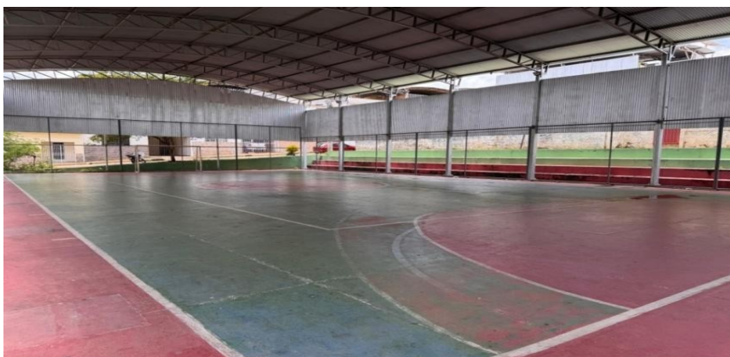
Figura 7- Quadra Poliesportiva (visão interna)
