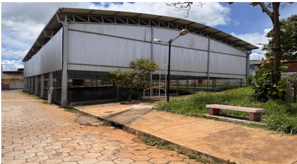
Figura 6- Quadra Poliesportiva (visão externa)
