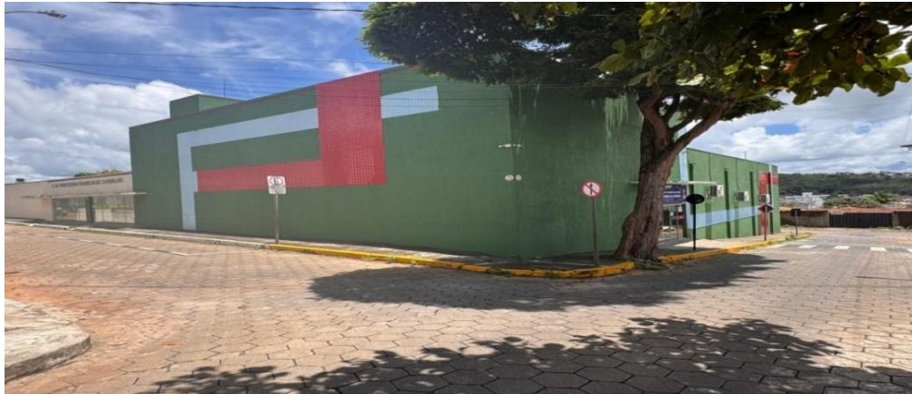
Figura 3- Fachada completa da Escola Municipal Professor Franklin de Carvalho
