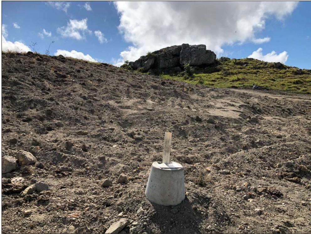
Figura 25: Praça de trabalho da sondagem em processo de recuperação
