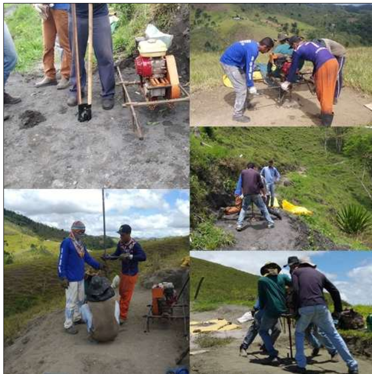
Figura 18: Perfuração com trado mecanizado
