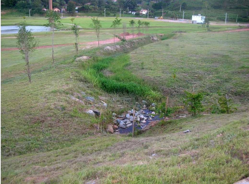
FIGURA 114: Reconformação de córrego no Loteamento Trilhas do Ouro, 2006.
