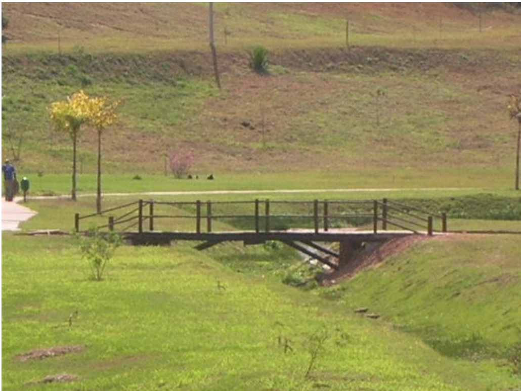
FIGURA 115: Reconformação de córrego no Loteamento Trilhas do Ouro, 2008.
