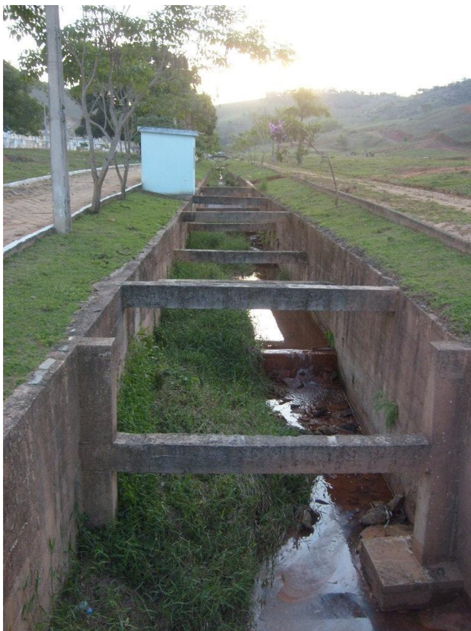
FIGURA 90: Canal do Loteamento Cidade Nova, set. 2008.
