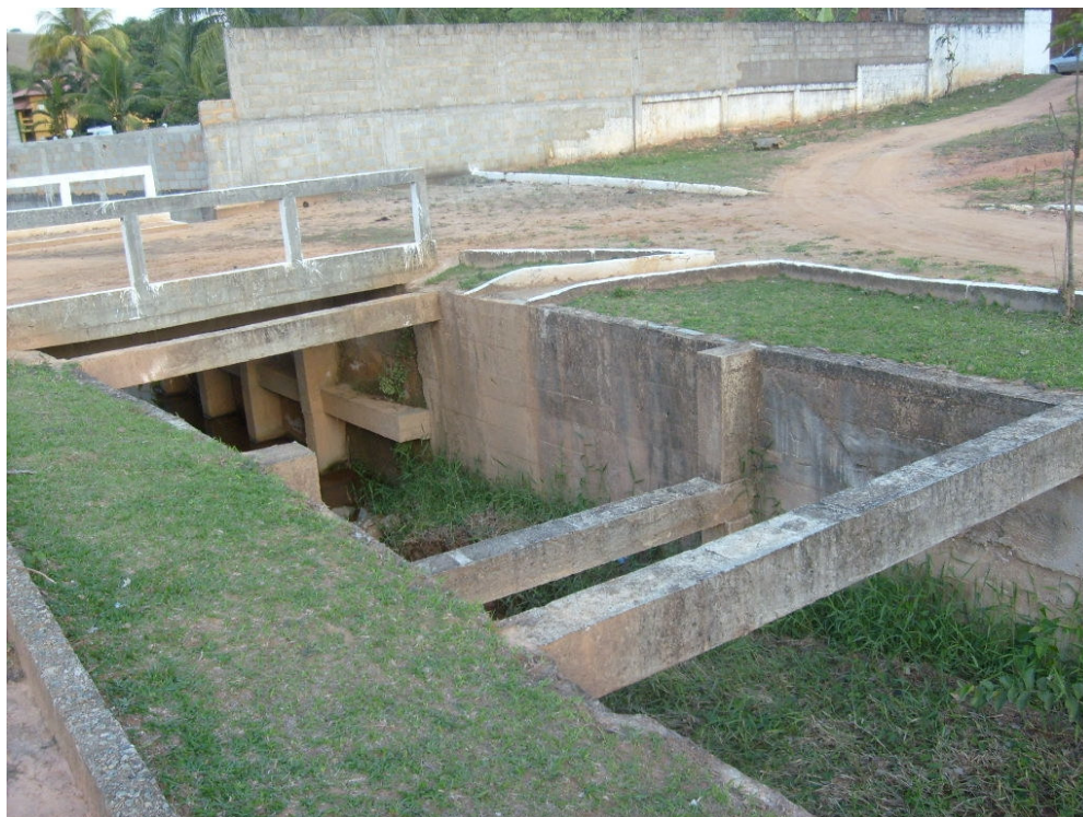
FIGURA 91: Canal do Loteamento Cidade Nova, set. 2008.
