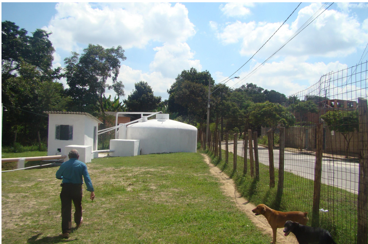
FIGURA 111: ETE Loteamento Vida Nova.
