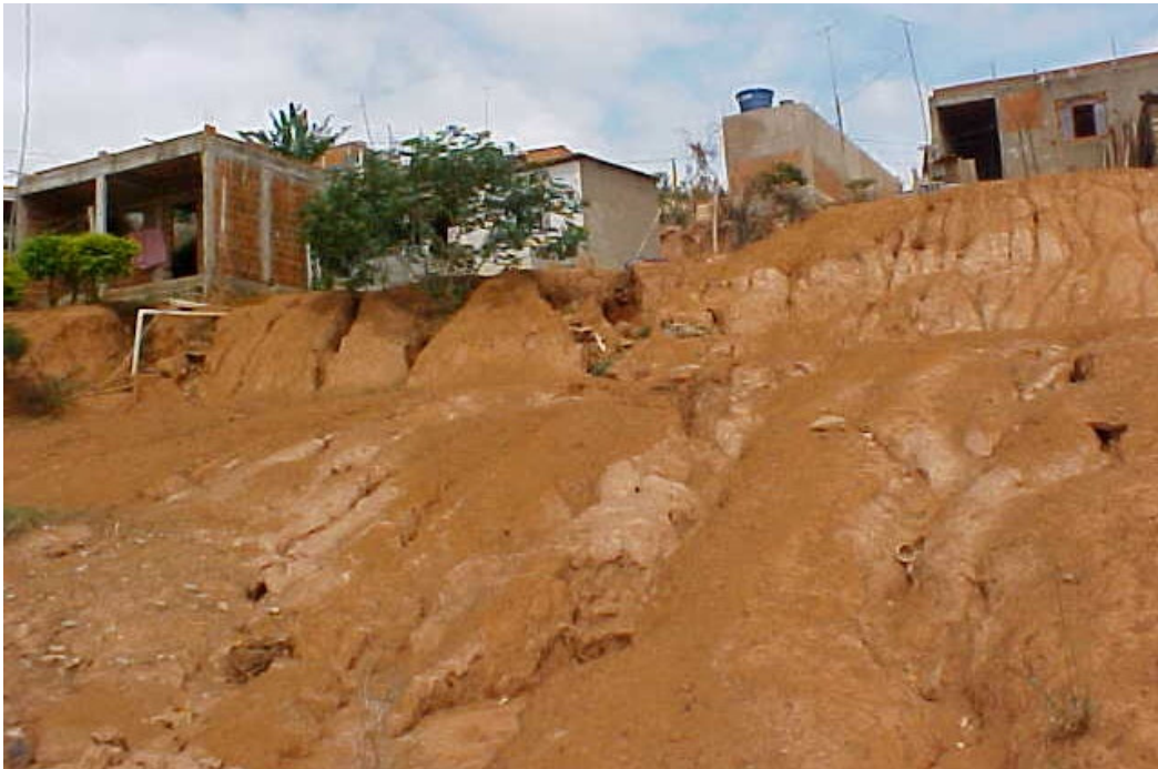
FIGURA 36: Erosão em loteamento, Santana do Paraíso/MG, 2003.
