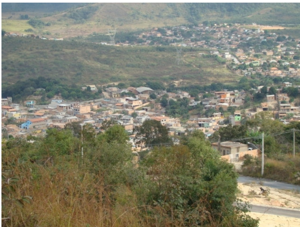
FIGURA 105: Vista do Loteamento Vida Nova, mai.-jun. 2009
