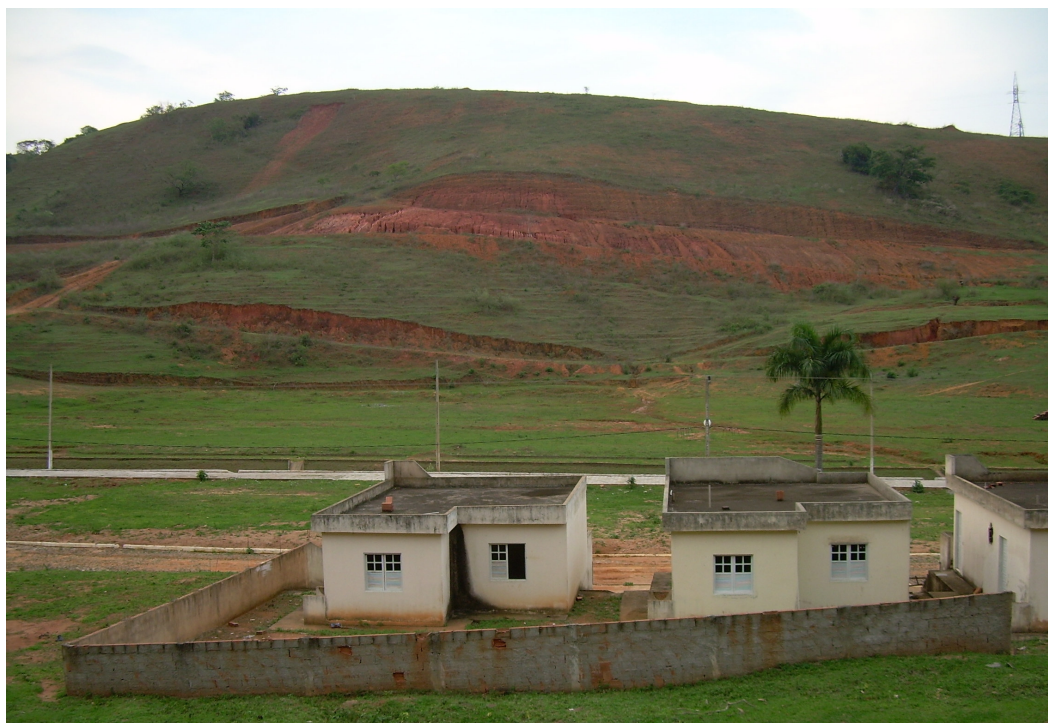
FIGURA 97: Casas do Loteamento Cidade Nova, out. 2008.
