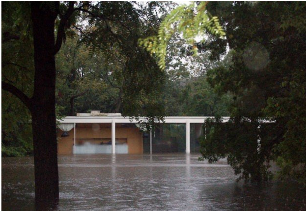
FIGURA 71: Inundação na Casa Farnsworth, 2008.
