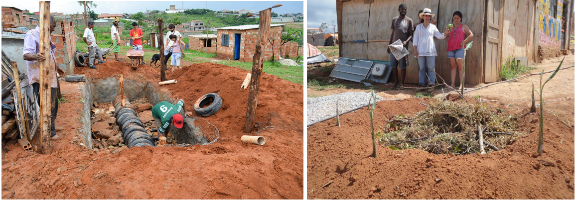
Figura 5 e 6: Mutirão de construção do TEVAP e do círculo de bananeira na ocupação Eliana Silva, com assessoria de professoras da Escola de Arquitetura da UFMG.
