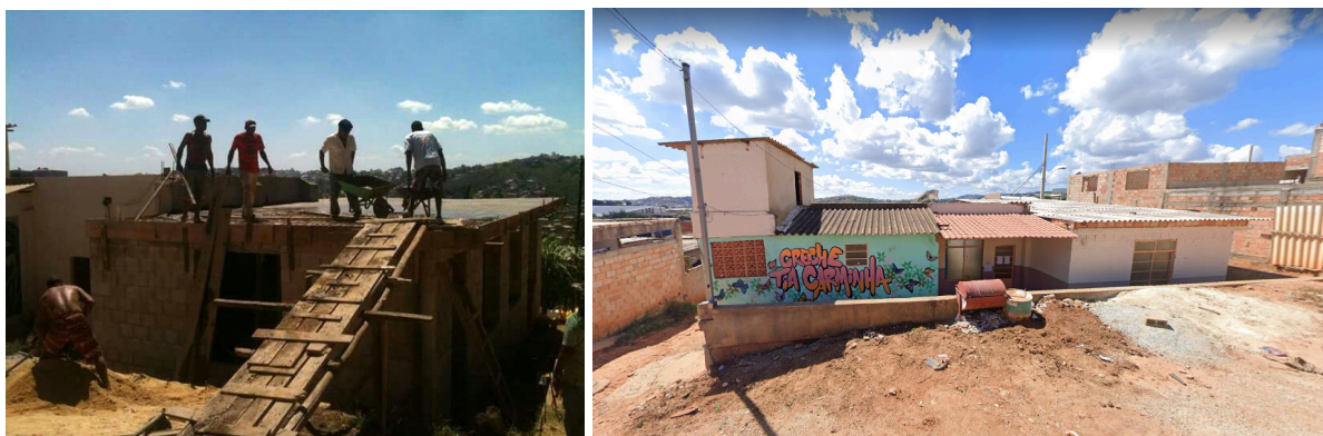
Figura 9 e 10: Ampliação da Creche Tia Carminha, na ocupação Eliana Silva, com projeto desenvolvido em parceria com a Escola de Arquitetura da UFMG.
