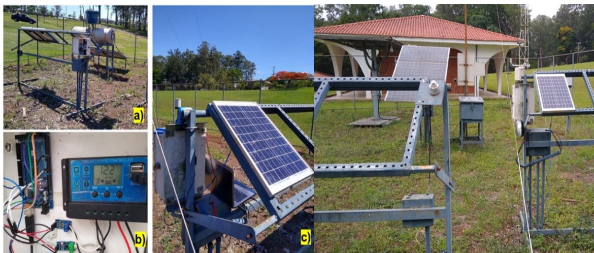
Figura 27 - Montagem experimental. (a) Suporte com módulo fotovoltaico, (b) Instalação da instrumentação e sensores, (c) Arranjo de equipamentos montados. (Fonte, Autoria Própria).
