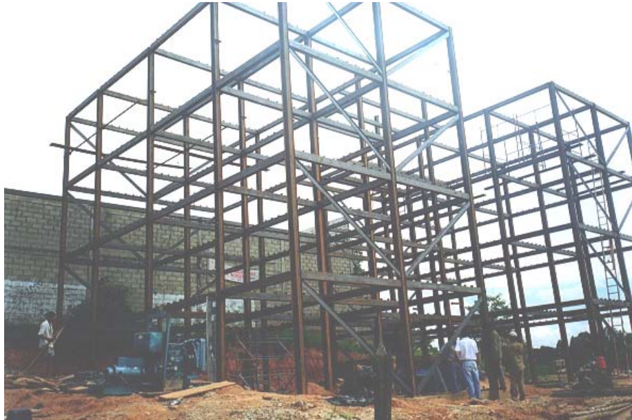
FIGURA 1.7 – Vista geral da estrutura de um prédio do Sistema COHAB-MG
