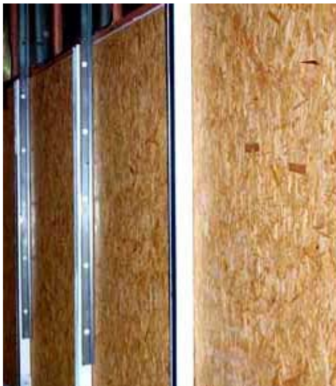
FIGURA 3.8 – Painel em LSF com fechamento em OSB (Fonte: Arquivo do autor)
