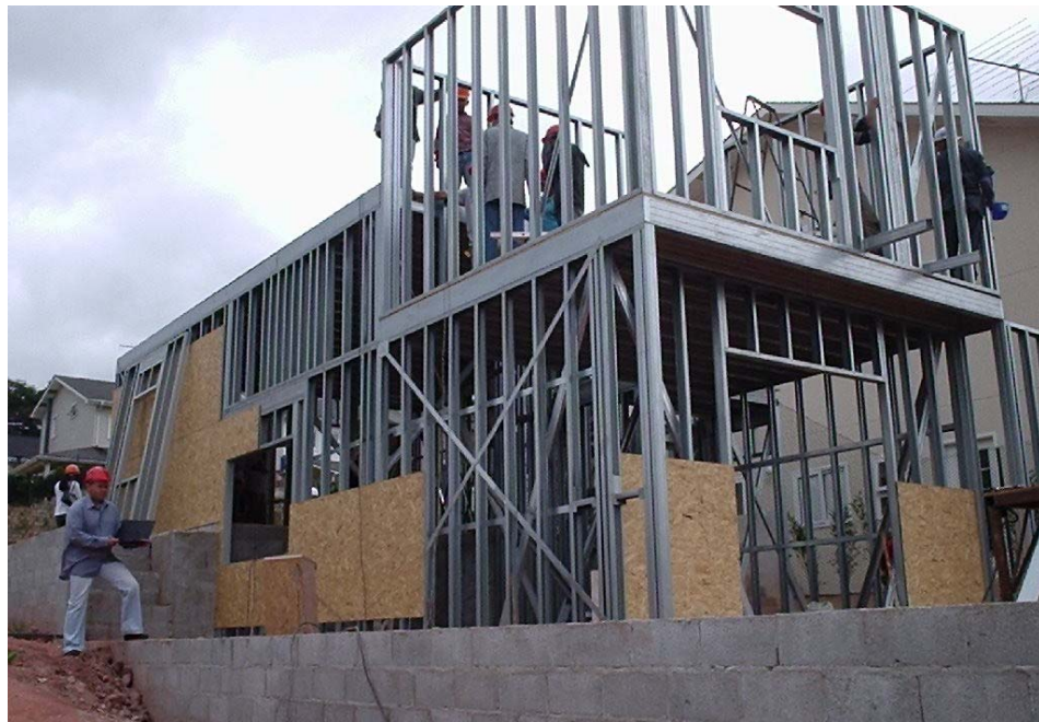
FIGURA 1.12 – Construção de uma residência em LSF (Fonte: arquivo do autor)
