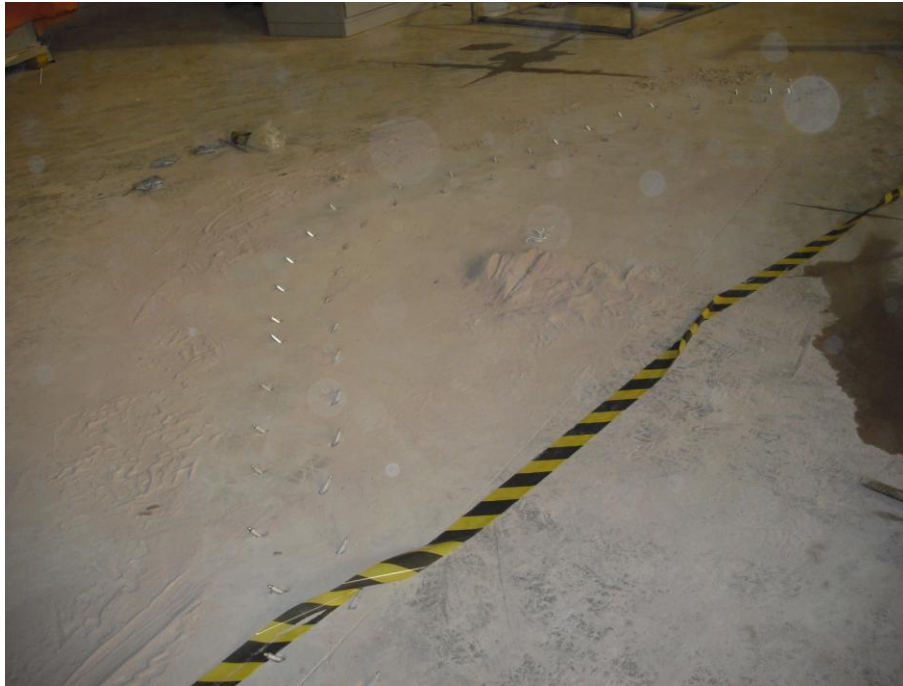
Figura 7.7: Colocação dos bicos injetores nas laterais e ao longo da fissura, G-Maia.
