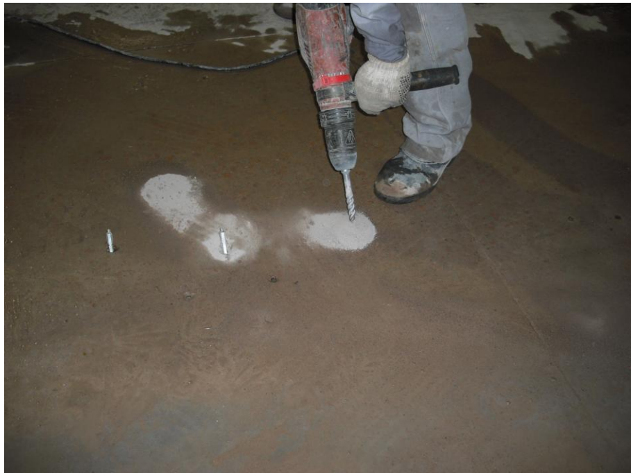
Figura 7.4: Perfuração inclinada com broca longa, G-Maia.
