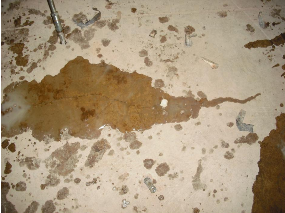
Figura 7.9: Injeção de Resina com ressurgimento na fissura, G-Maia.
