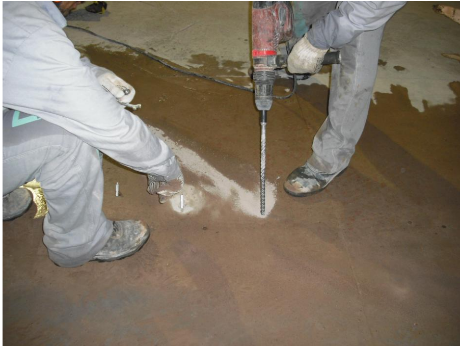
Figura 7.5: Perfuração inclinada com broca longa, G-Maia.
