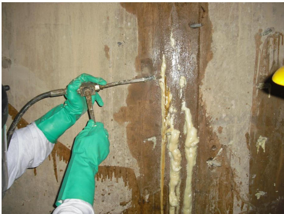
Figura 7.15: Injeção espuma de poliuretano para vedação da fissura, G-Maia.
