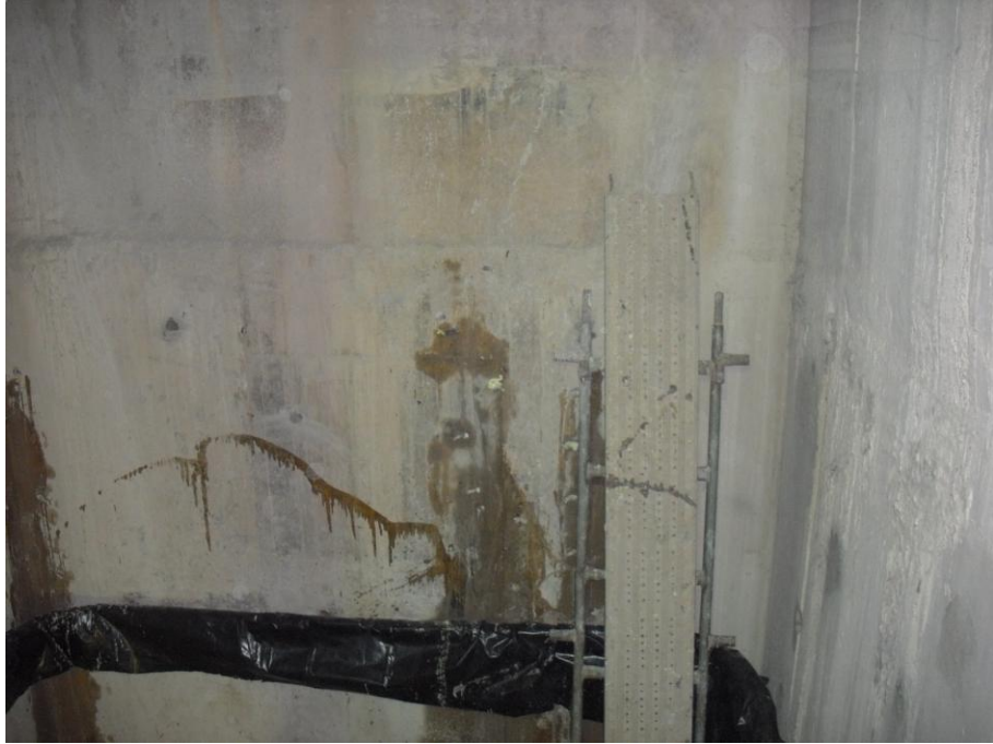
Figura 7.16: Aspecto após aplicação e limpeza.
