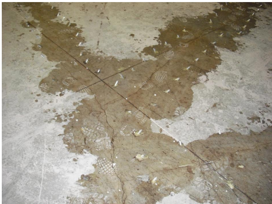
Figura 7.10: Aspecto após aplicação da resina, G-Maia.
