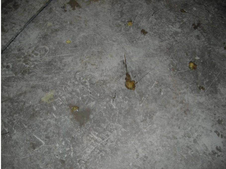
Figura 7.11: Retirada dos bicos injetores por corte, G-Maia.
