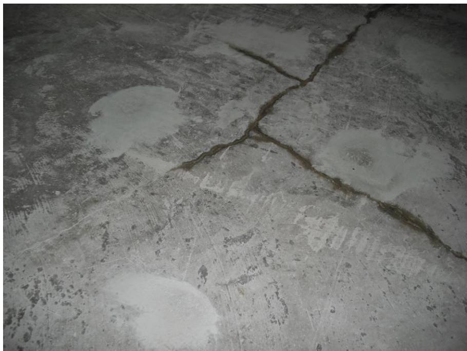
Figura 7.12: Aspecto após execução do serviço, G-Maia.
