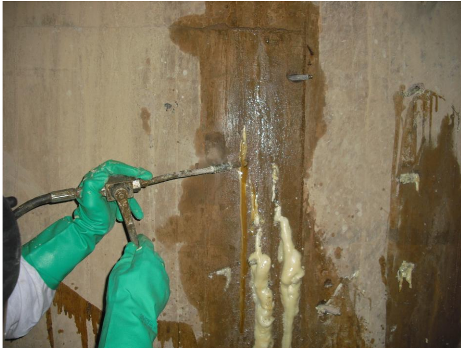
Figura 7.14: Injeção espuma de poliuretano para vedação da fissura, G-Maia.
