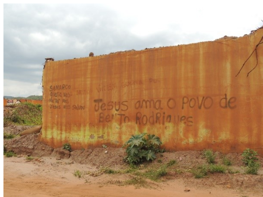
FIGURA 85 Inscrição nas paredes das edificações remanescentes: “Jesus ama o povo de Bento Rodrigues” e “SAMARCO queria nos matar, mas Jesus nos salvou”
