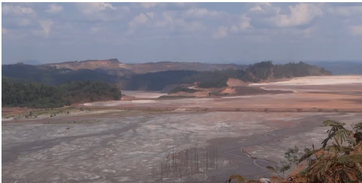
FIGURA 78 Barragem de Germano a frente, e ao fundo, trecho da Mina da Alegria.
