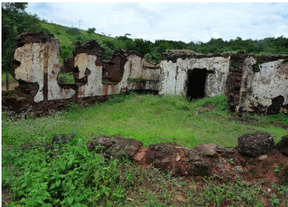
FIGURA 12 Ruínas da Antiga Vila de Gongo Soco, Barão de Cocais/MG, patrimônio minerário de Minas Gerais.
