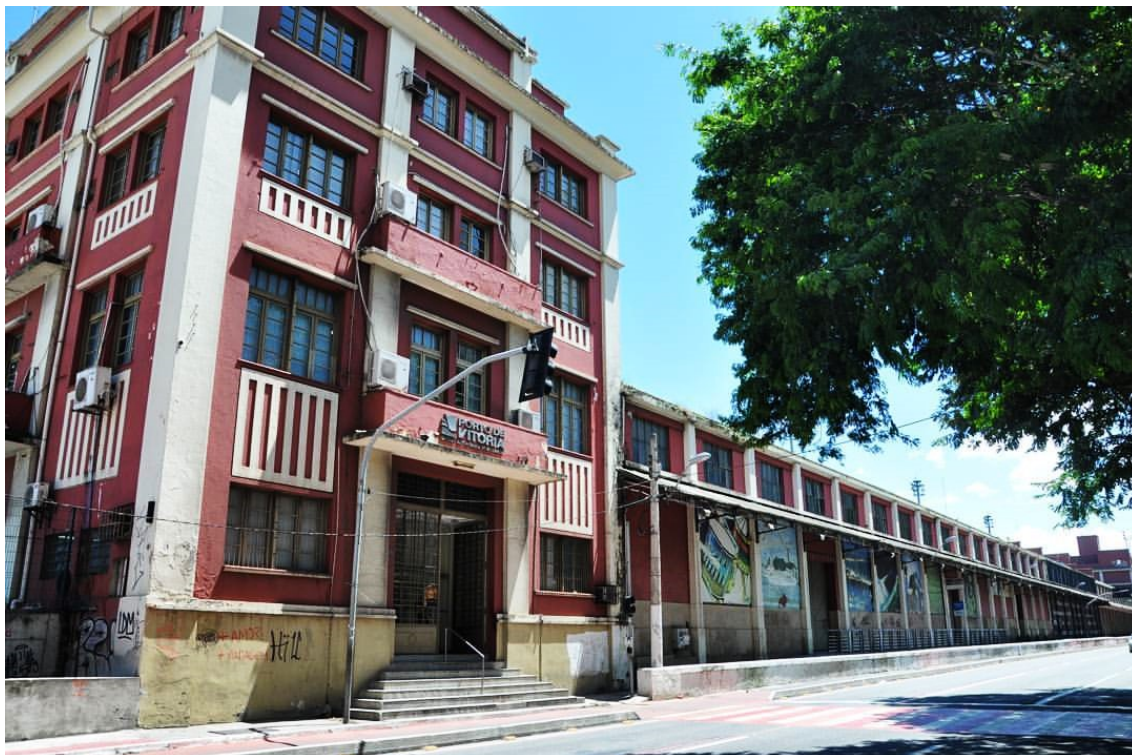
FIGURA 18 Fachada do Porto de Vitória com processo de Instrução aberto no IPHAN desde 2015.
