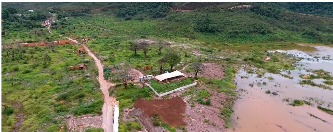
FIGURA 83 Dique S4 a direita, e povoado de Bento Rodrigues a esquerda da imagem, dois anos após o rompimento da barragem.
