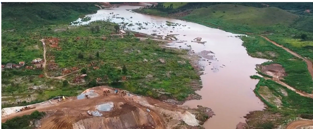
FIGURA 64 Dique S4 e povoado de Bento Rodrigues a esquerda da imagem, dois anos após o rompimento da barragem.
