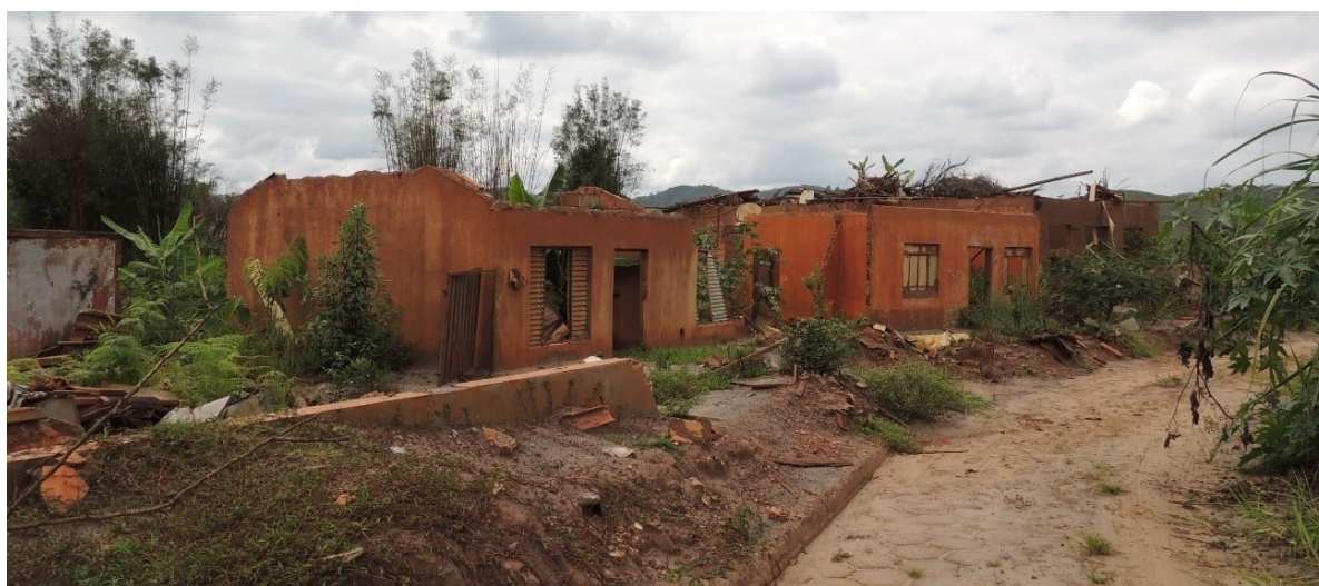
FIGURA 82 Edificações atingidas de Bento Rodrigues em 2016.
