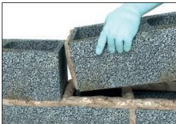
Figura 4: Argamassa de Assentamento
