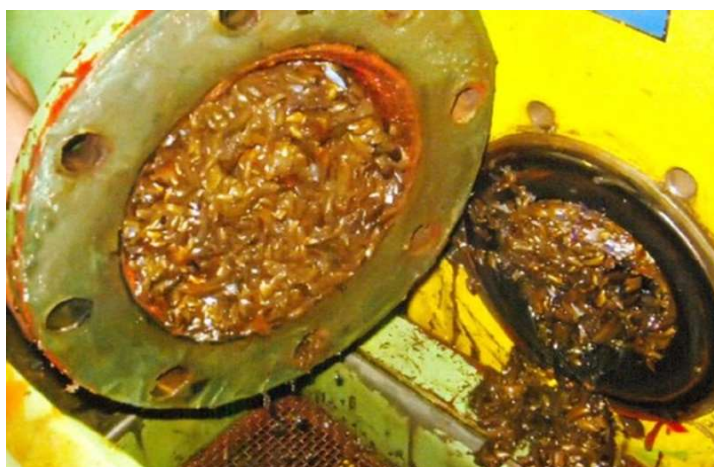
FIGURA 3 - Conduto totalmente ocluído, sob infestação pelo MD. FONTE: EBANATAW, 2019.
