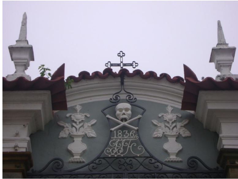
Foto 4 – Fachada do Cemitério da Ordem Terceira do Carmo em São João del-Rei, inaugurado em 1836. Foto: Edésio de Lara Melo.
