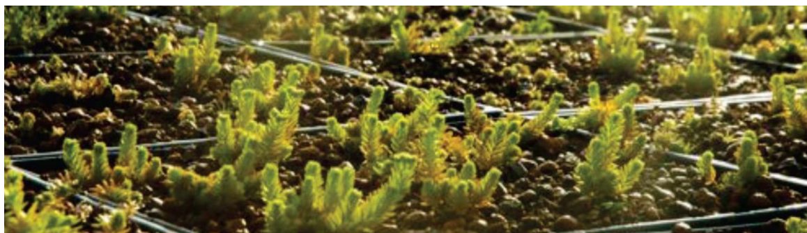
Figura 10 - Telhado verde com sistema modular. Fonte: Instituto Cidade Jardim (2010).
