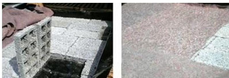
Figura 29 - Módulos sobre laje impermeabilizada e colocação da membrana de retenção. Fonte: www.revistatechne.com.br/engenharia-civil (2011).
