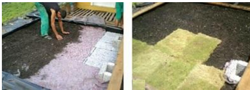
Figura 30 - Colocação de substrato leve fibroso e os feixes de grama são encaixadas. Fonte: www.revistatechne.com.br/engenharia-civil (2011).
