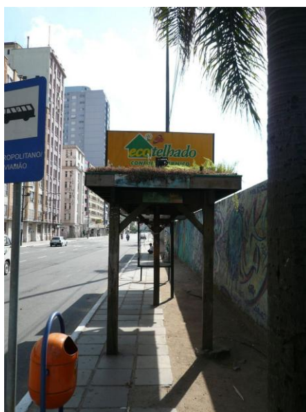
Figura 49 - Parada de Ônibus Ecológica utilizando sistema alveolar, Porto Alegre/RS. Fonte: Marco Milazzo & Associados (2010).
