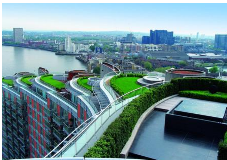
Figura 7 - Telhado verde extensivo. Fonte: www.umahku.com/architecture-concept/green-building-design-in-urban-areas (2010).
