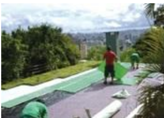
Figura 24 - Colocação da membrana de retenção. Fonte: www.revistatechne.com.br/engenharia-civil (2011).
