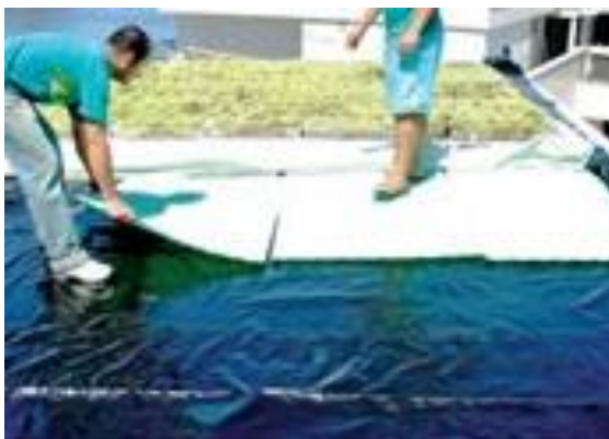
Figura 23 - Colocação da membrana de retenção sobre a membrana antirraízes. Fonte: www.revistatechne.com.br/engenharia-civil (2011).
