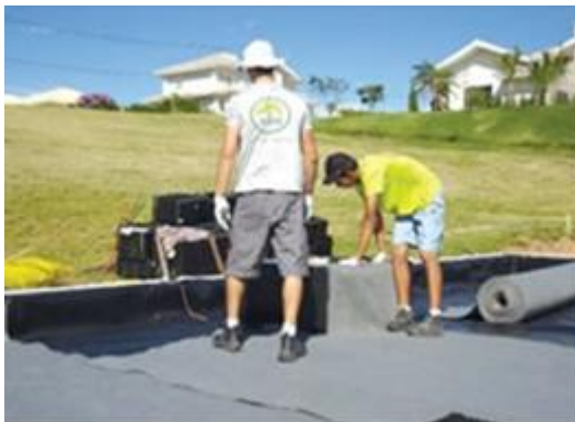
Figura 12 - Impermeabilização e proteção mecânica. Fonte: www.revistatechne.com.br/engenharia-civil (2011).
