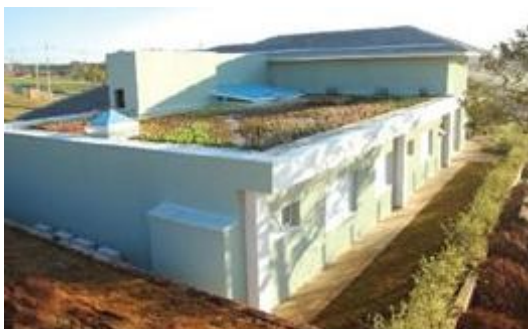
Figura 20 - Jardim suspenso com seis meses após plantio. Fonte: www.revistatechne.com.br/engenharia-civil (2011).
