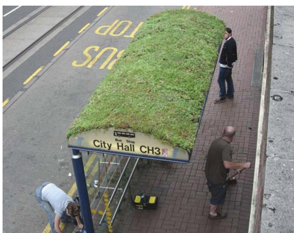
Figura 48 - Ponto de ônibus com telhado de grama em Sheffield, Inglaterra. Fonte: www.mastchulbule.com (2011).
