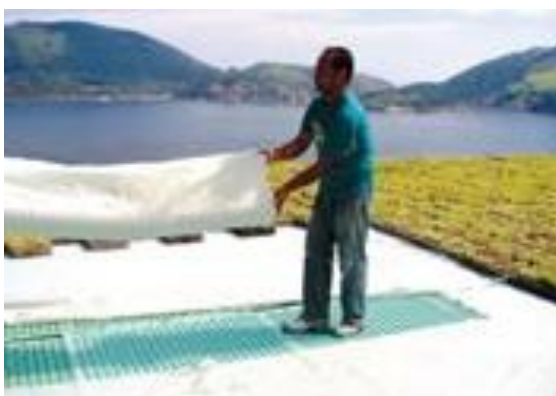
Figura 25 - A membrana alveolar é cortada e aplicada. Fonte: www.revistatechne.com.br/engenharia-civil (2011).
