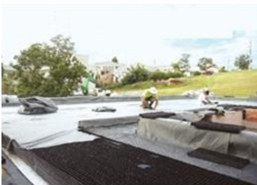
Figura 14 - Camada de filtragem e separação. Fonte: www.revistatechne.com.br/engenharia-civil (2011).
