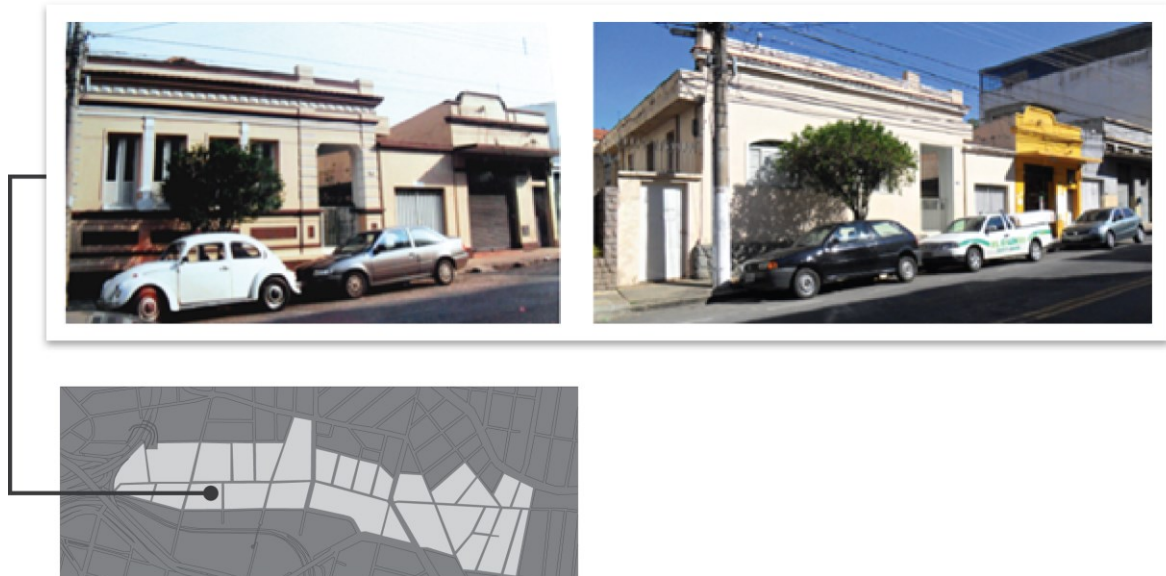
Figura 41: Rua Pouso Alegre, 396 – descaracterização do bem tombado
