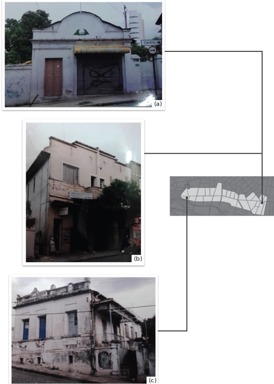
Figura 8: Típicas residências do início da ocupação da rua Pouso Alegre
