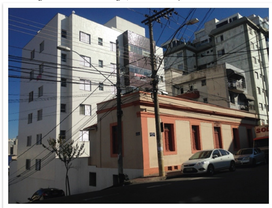
Figura 36: Rua Pouso Alegre, 404 – restauração do bem tombado
