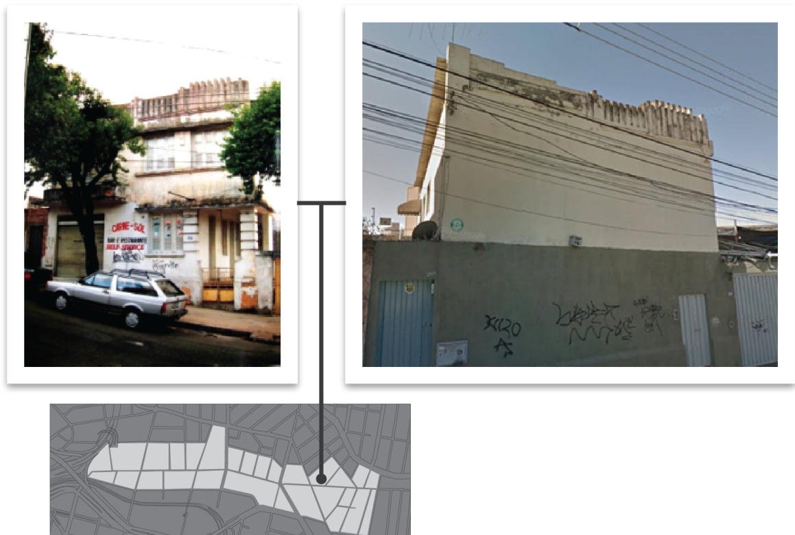
Figura 38: Rua Pouso Alegre, 1.247 – descaracterização do bem tombado
