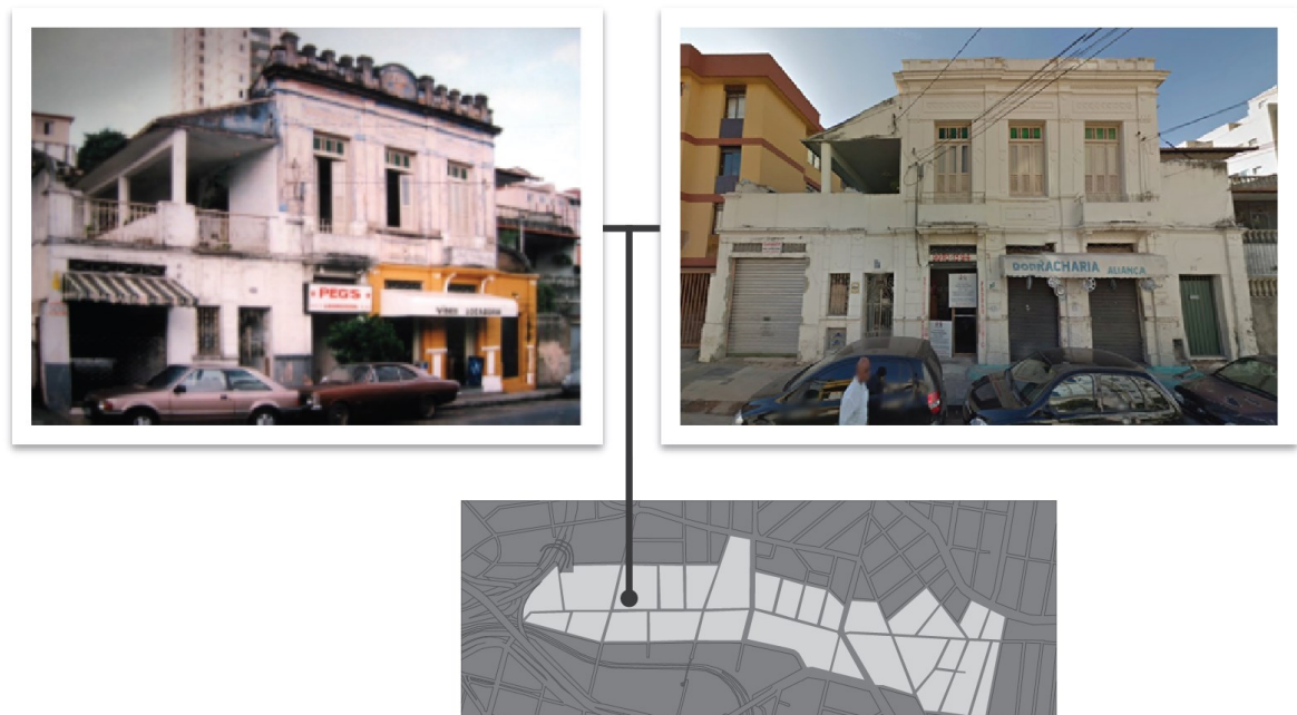
Figura 42: Rua Pouso Alegre, 357 – descaracterização do bem tombado
