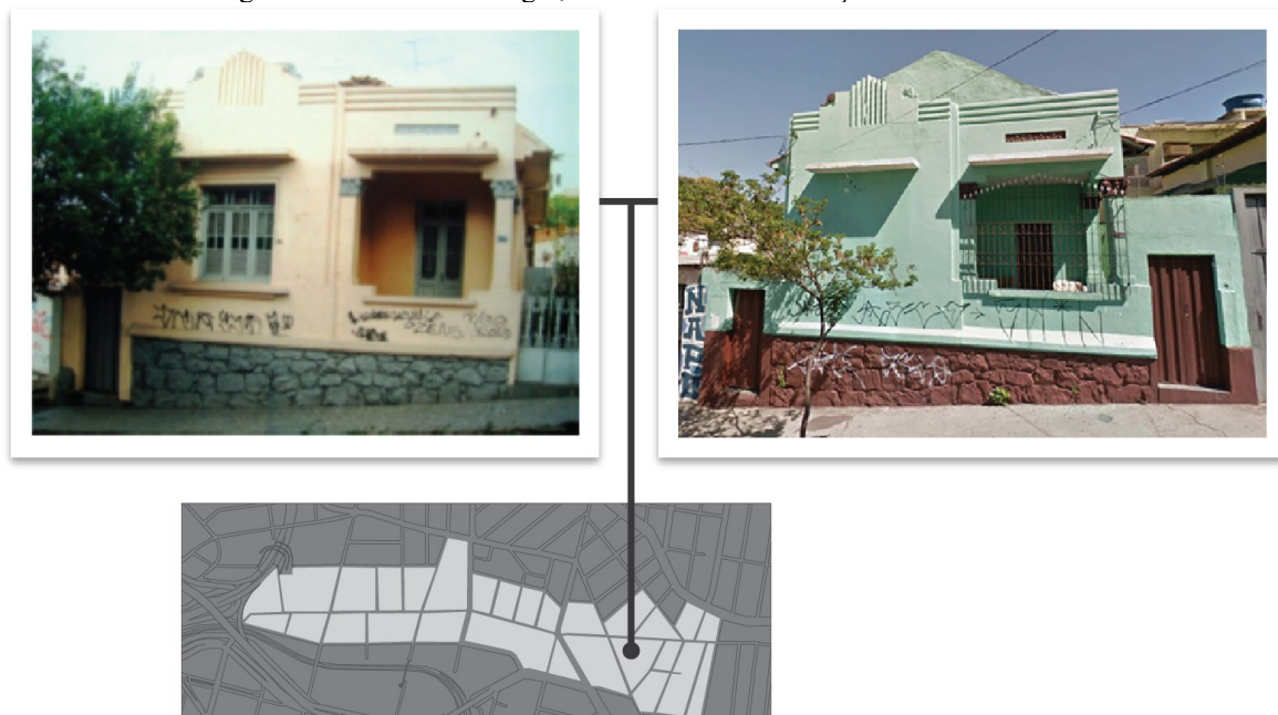
Figura 39: Rua Pouso Alegre, 1.222 – descaracterização do bem tombado
