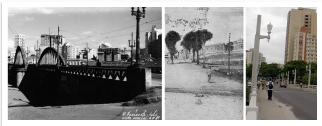
Figura 11: Vistas dos viadutos de Santa Tereza e Floresta
