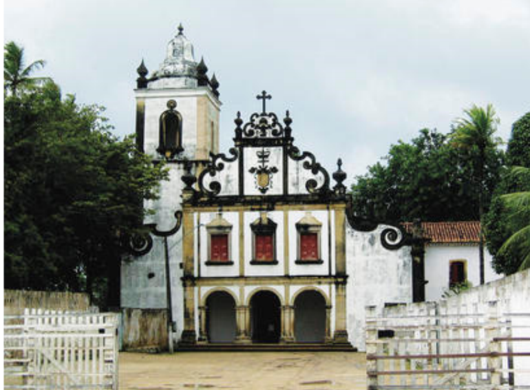
FIGURA 38 – Fachada da Igreja e Convento de Santo Antônio de Igarassu/ PE
