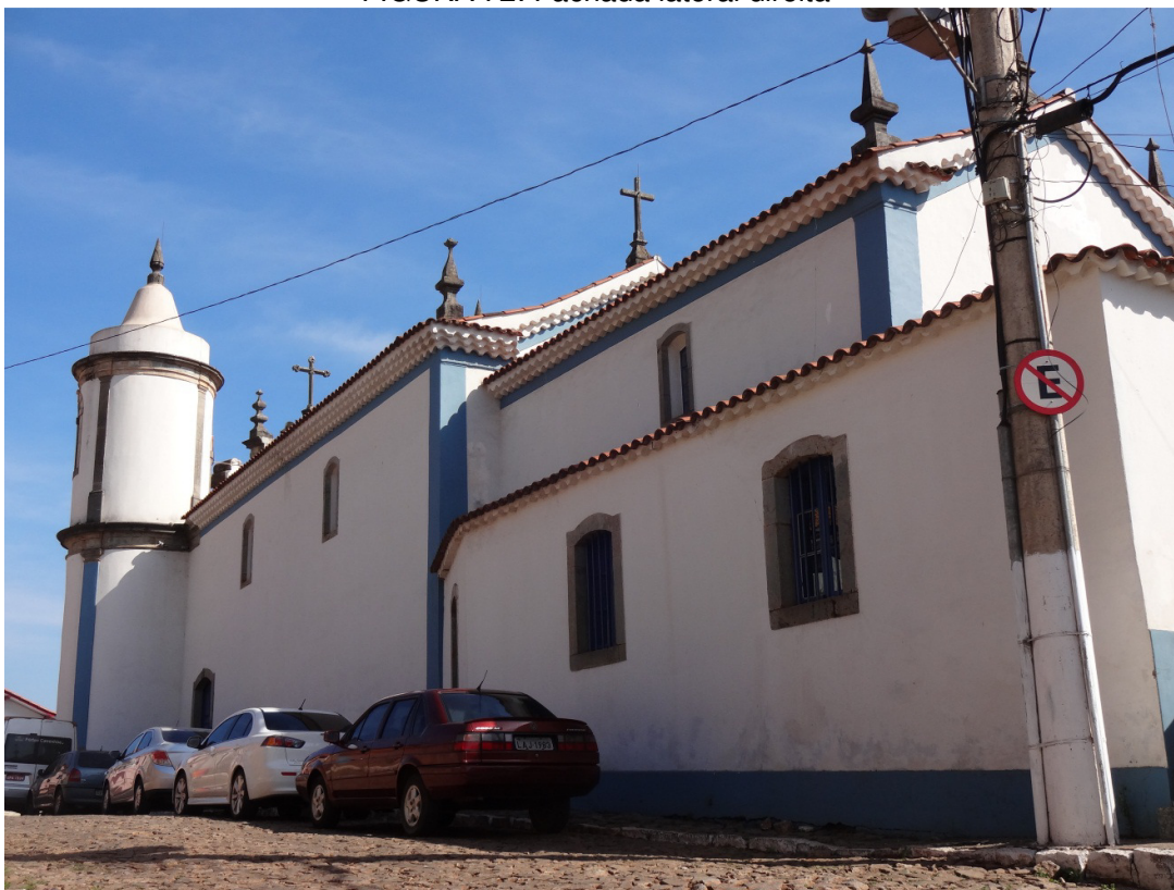
FIGURA 72: Fachada lateral direita
