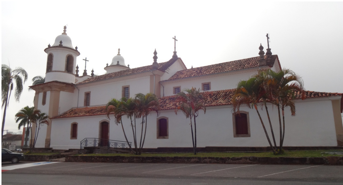
FIGURA 49: Fachada lateral direita
