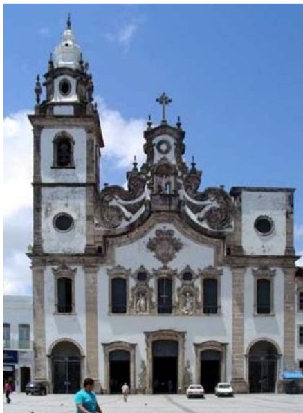
FIGURA 60 – Igreja do Carmo, Recife/ PE
