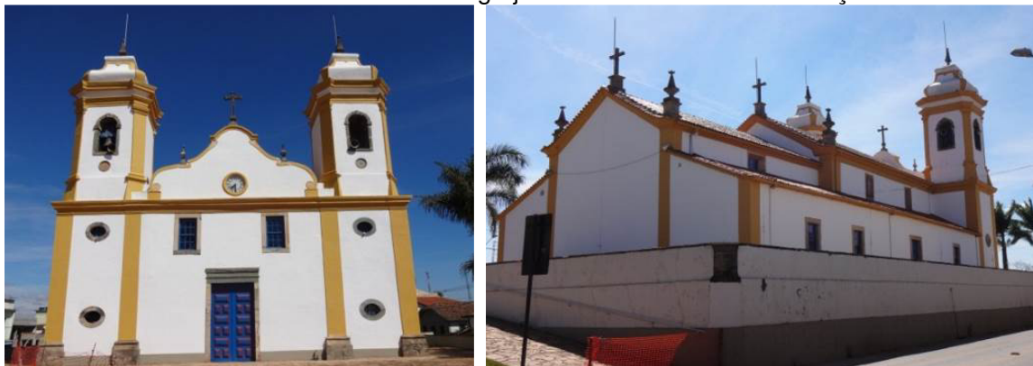
FIGURA 91 – Fachada frontal e lateral da Igreja Matriz de São Brás do Suaçuí/ MG
