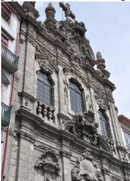
FIGURA 20 – Fachada da Igreja da Misericórdia, Porto/ Portugal
