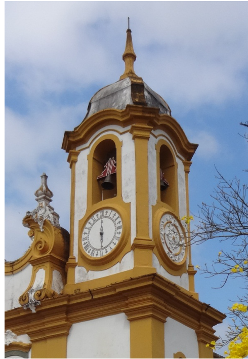
FIGURA 12: Parte superior da torre, com cantos chanfrados, sino e rosetas
