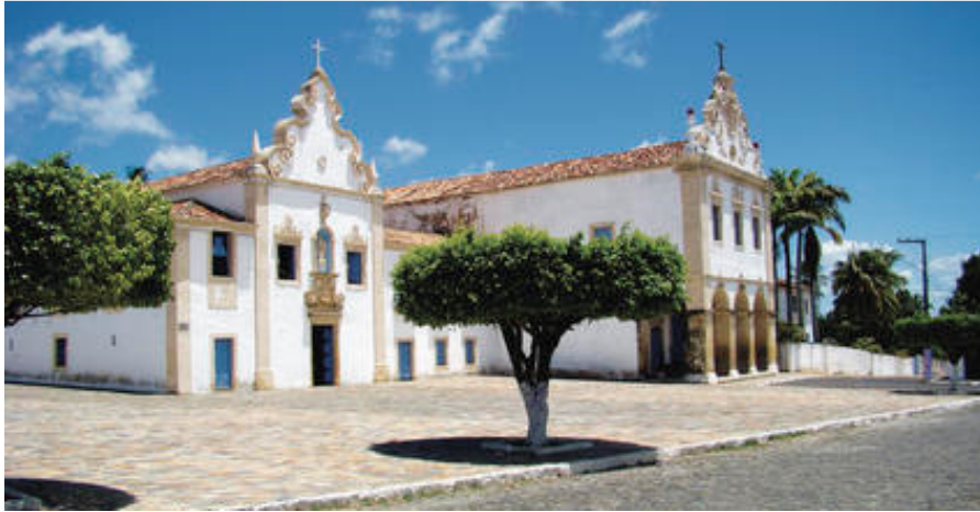
FIGURA 43 – Fachada do Convento dos Carmelitas, São Cristóvão/ SE
