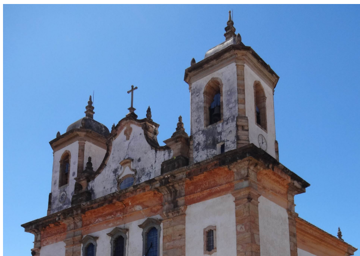
FIGURA 87 – Torres chanfradas da Igreja Matriz de Nossa Senhora do Bonsucesso, Caeté/ MG
