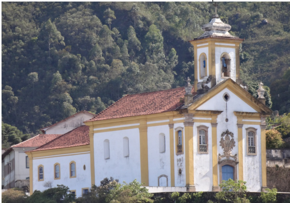
FIGURA 41: Fachada frontal e lateral esquerda
