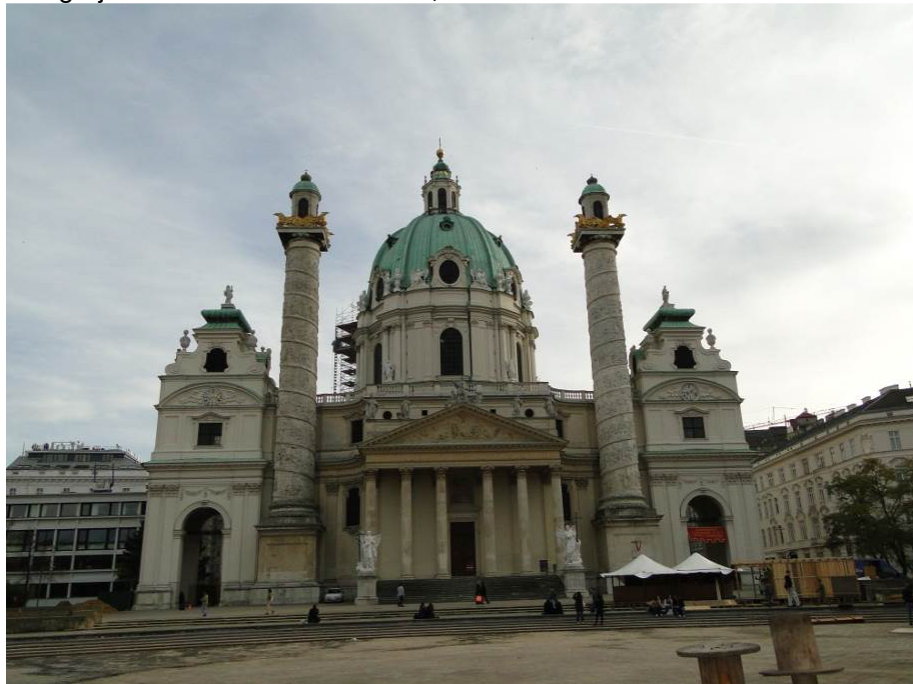
FIGURA 1 – Igreja de São Carlos Borromeo, Viena/ Áustria
