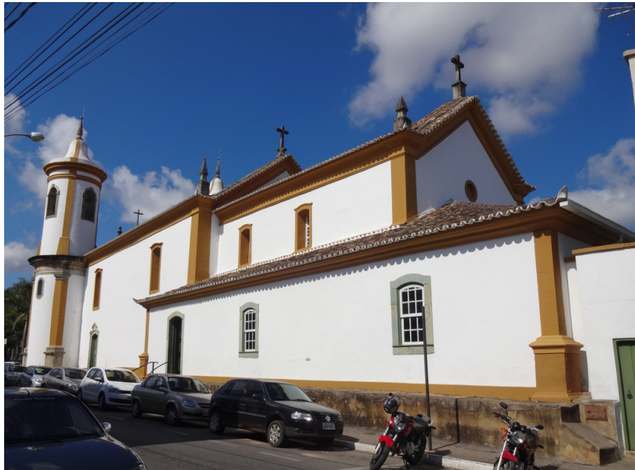
FIGURA 31: Fachada lateral direita
