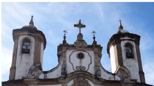
FIGURA 85 – Frontão da Igreja de Nossa Senhora do Carmo, Ouro Preto/ MG
