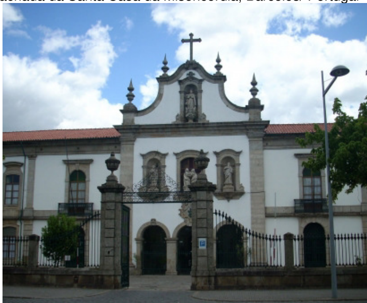
FIGURA 41 – Fachada da Santa Casa da Misericórdia, Barcelos/ Portugal
