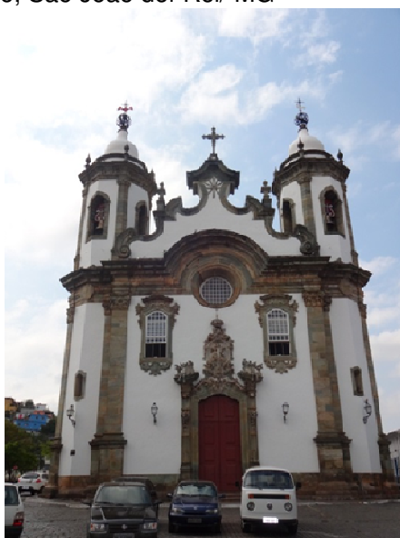
FIGURA 83 – Igreja de Nossa Senhora do Carmo, São João del-Rei/ MG
