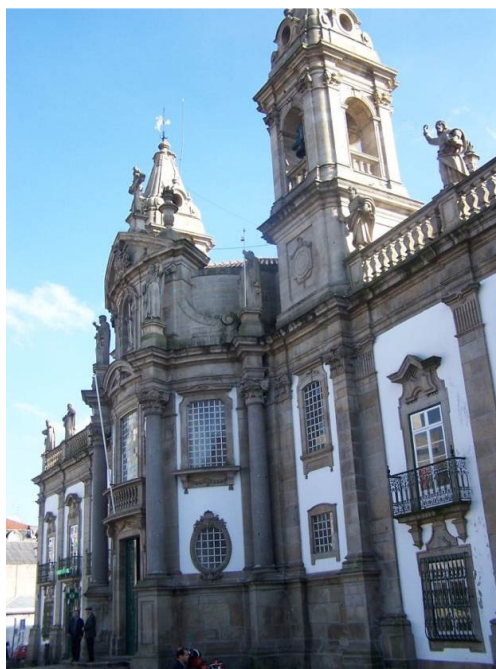
FIGURA 29 – Bombeamento da fachada do hospital de São Marcos da Misericórdia, Braga/ Portugal
