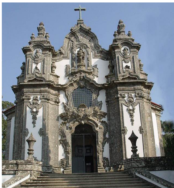
FIGURA 23 – Fachada frontal da Capela de Santa Maria Madalena da Falperra, Braga/ Portugal
