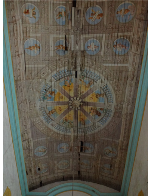
FIGURA 47: Forro da nave
