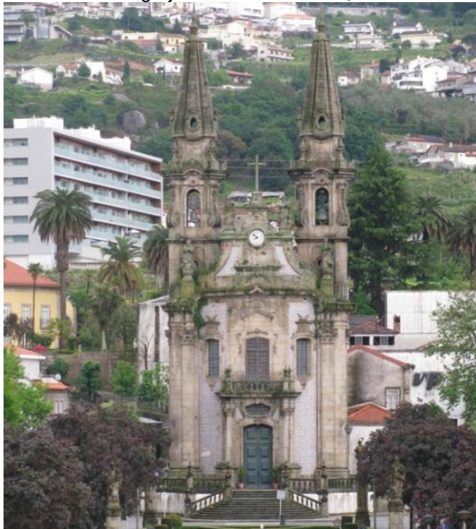
FIGURA 26 – Fachada frontal da Igreja dos Santo Passos, Guimarães/ Portugal
