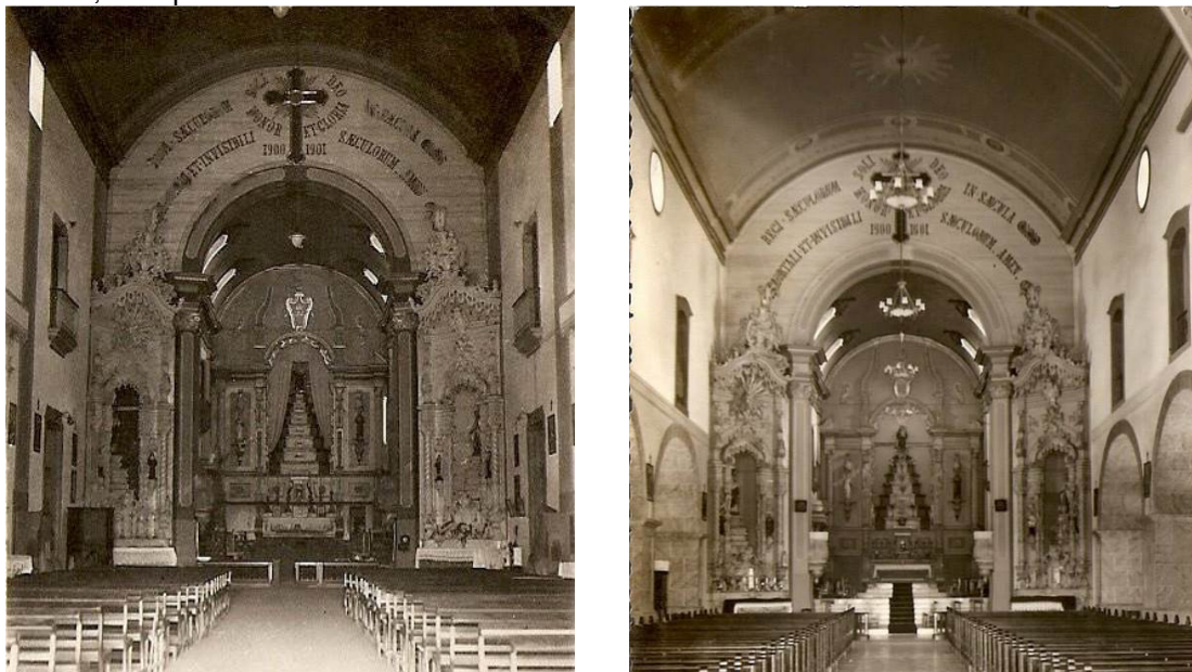
FIGURA 101 – Interior da nave antes e após a reforma de 1948 da Catedral de Santo Antônio, Campanha/ MG
