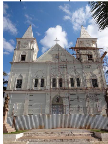
FIGURA 100 – Fachada da Catedral de Santo Antônio, Campanha/ MG. Após 1925
