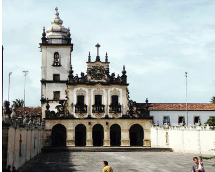
FIGURA 39 – Fachada da Igreja de São Francisco do Convento de Santo Antônio de João Pessoa/ PB
