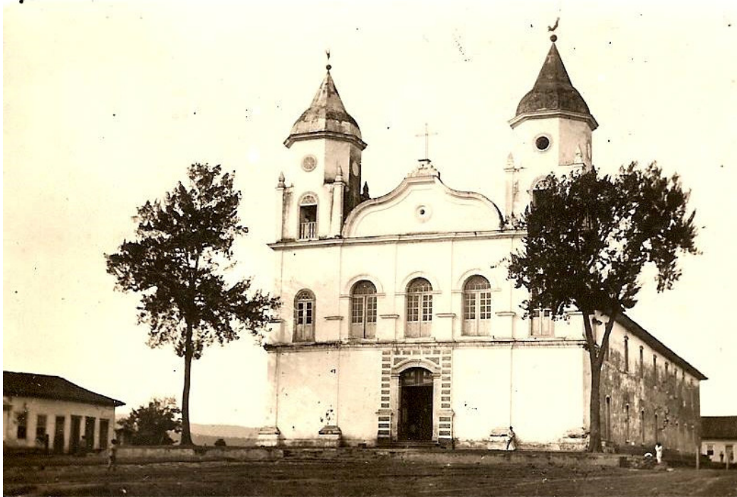
FIGURA 57: Fachada frontal e lateral direita até 1925
