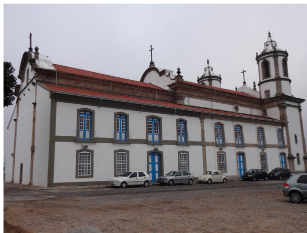
FIGURA 62: Fachada lateral direita após 1957
