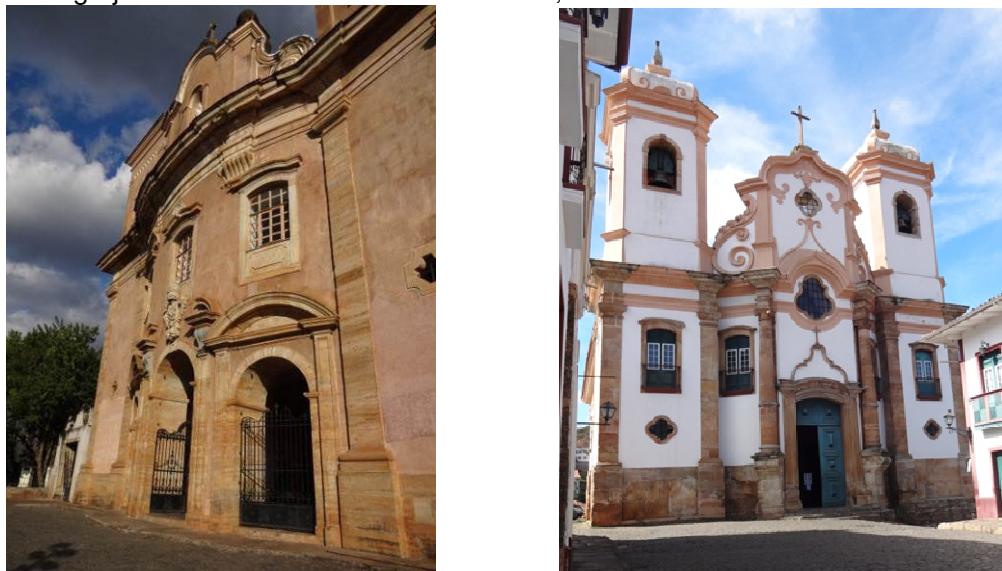
FIGURA 88 – Bombeamento do frontispício da Igreja de São Pedro dos Clérigos, Mariana/ MG e da Igreja Matriz de Nossa Senhora do Pilar, Ouro Preto/ MG
