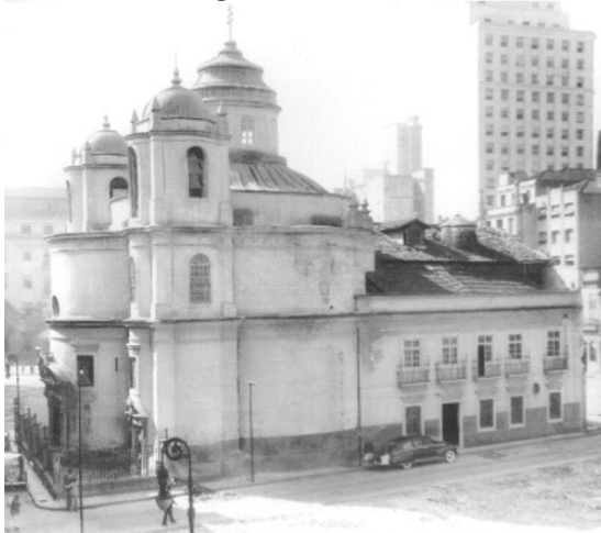
FIGURA 51 – Vista lateral da Igreja de São Pedro dos Clérigos, Rio de Janeiro/ RJ
