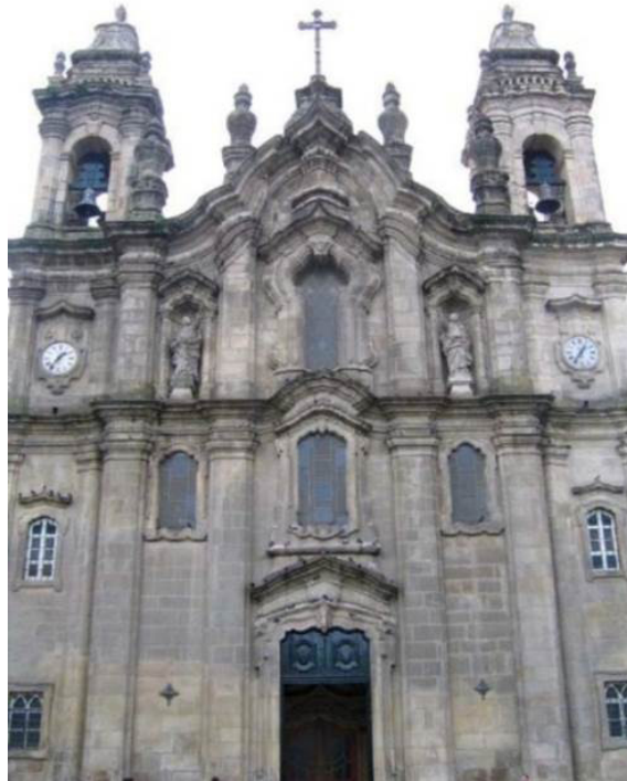
FIGURA 25 – Fachada frontal da Igreja do Convento dos Congregados, Braga/ Portugal
