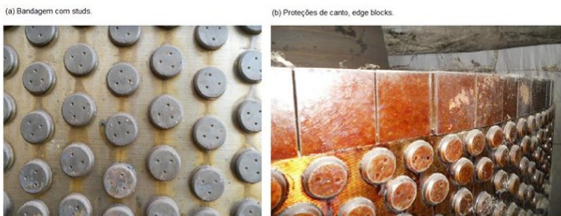
Figura 7 - Proteções utilizadas nas bandagens em geral: (a) studs ; (b) edgeblocks
