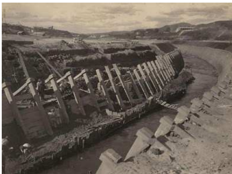
Figura 3.1: Canalização do Ribeirão Arrudas pelo processo Ravier em frente ao Parque Municipal em Belo Horizonte. Fonte: APM (Arquivo Público Mineiro). Foto: Gines Gea Ribera, 1926-1930.
