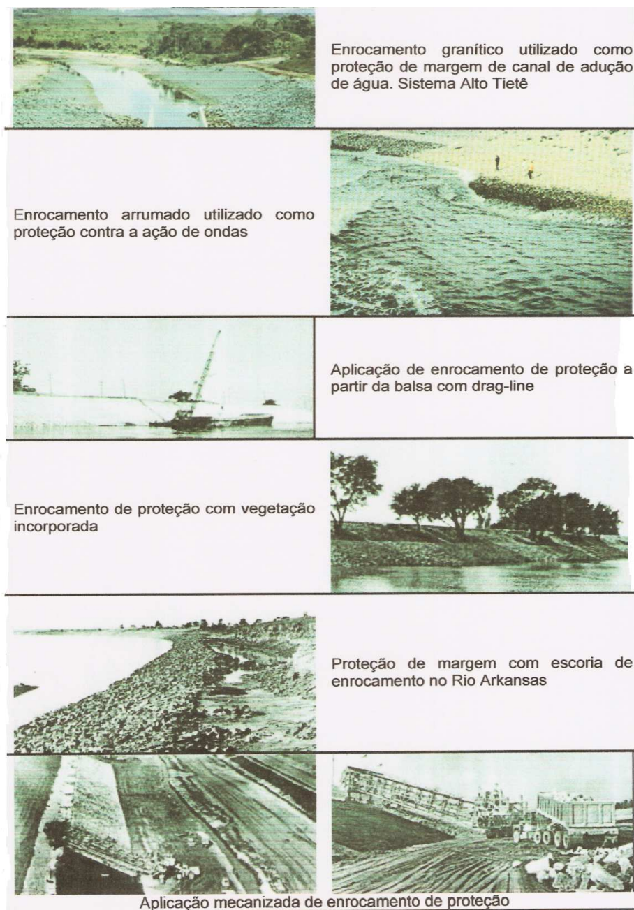
Figura 3.13: Exemplos de aplicação de enrocamentos. Fonte: Brighetti, 2001.
