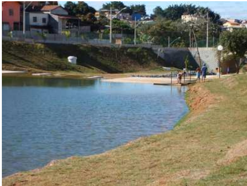
Figura 3.3: Córrego Nossa Senhora da Piedade, em Belo Horizonte, revitalizado. Fonte: Projeto Manuelzão. Foto: Fundep/Drenurbs, 05/2008.
