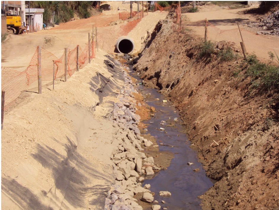
Figura 5.2: Obra em andamento, junho/2010. Início do Córrego Cascatinha em leito aberto e abertura de via na margem direita do mesmo. Foto: Guilherme Póvoa.
