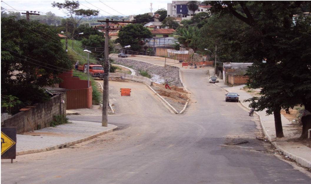
Figura 5.3: Obra acabada, abril/2011. Verifica-se a pista pavimentada na margem direita do Córrego Cascatinha e o mesmo em leito aberto com enrocamento. Foto: Guilherme Póvoa.
