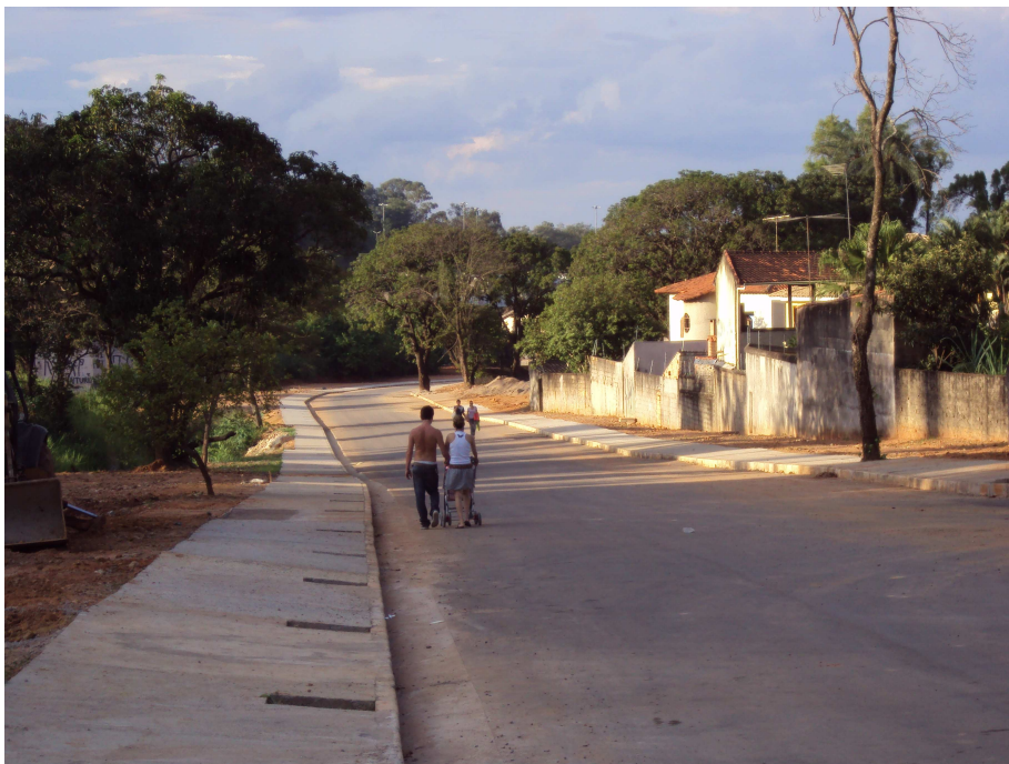
Figura 5.4: Obra Acabada, abril/ 2011. Parte do trecho em estudo a jusante do ponto 1. Foto: Guilherme Póvoa.
