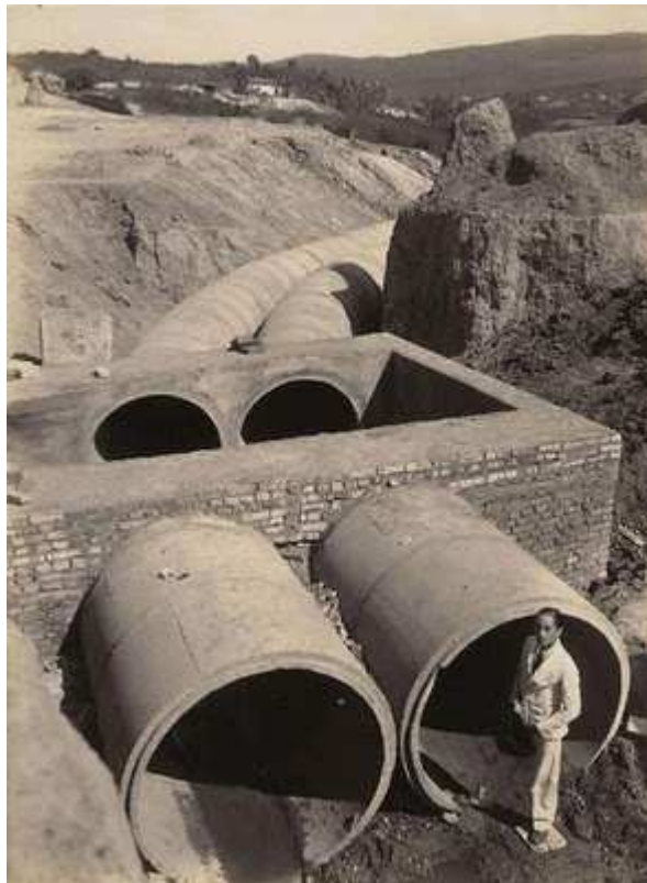
Figura 3.4: Canalização do Córrego do Leitão em Belo Horizonte. Sobre as manilhas foi aberta a Rua Bárbara Heliodora. Fonte: APM (Arquivo Público Mineiro). Foto: Gines Gea Ribera, 1931.
