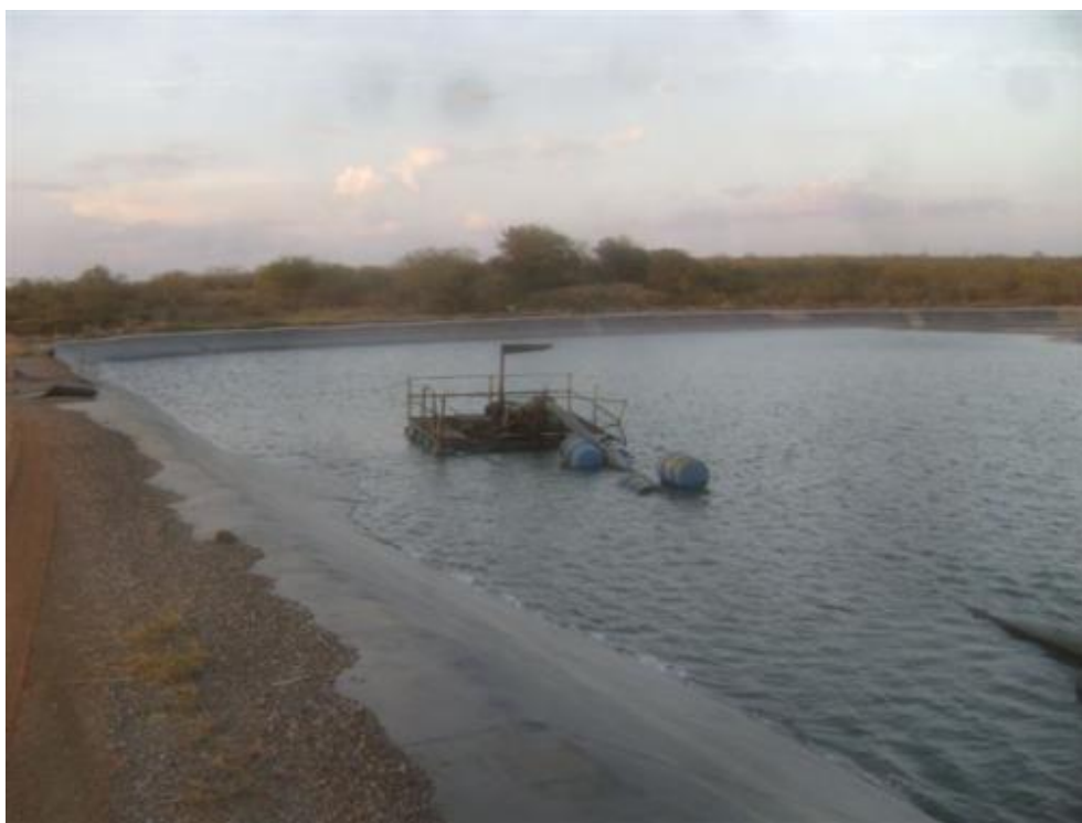
Figura 3-9 – Lago II – Vista do reservatório e espaldares revestidos com GM de PVC
