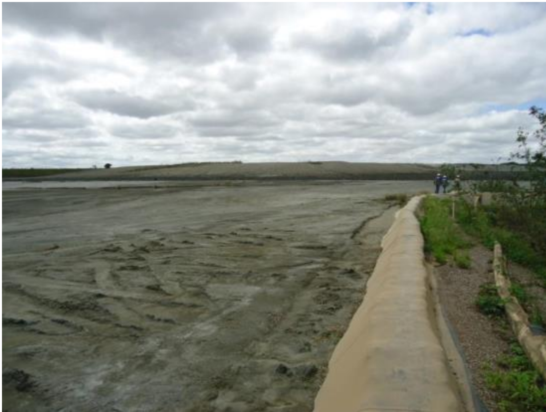
Figura 3-26 – Lago II – Vista do reservatório (Lago II)
