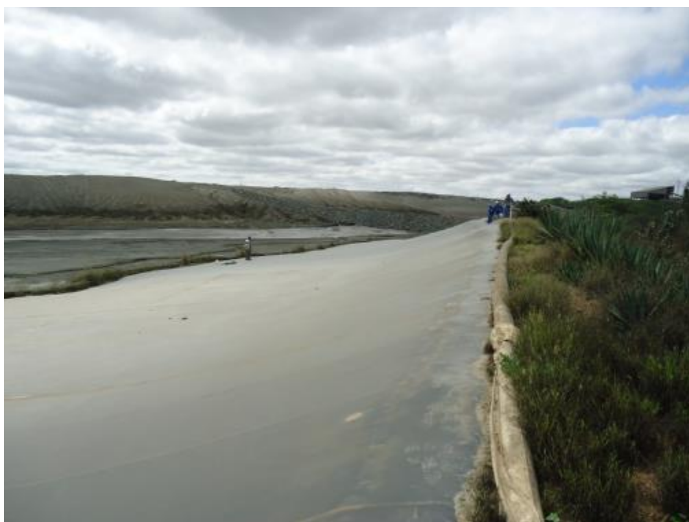
Figura 3-12 – Lago II - Espaldares revestidos com GM de PVC
