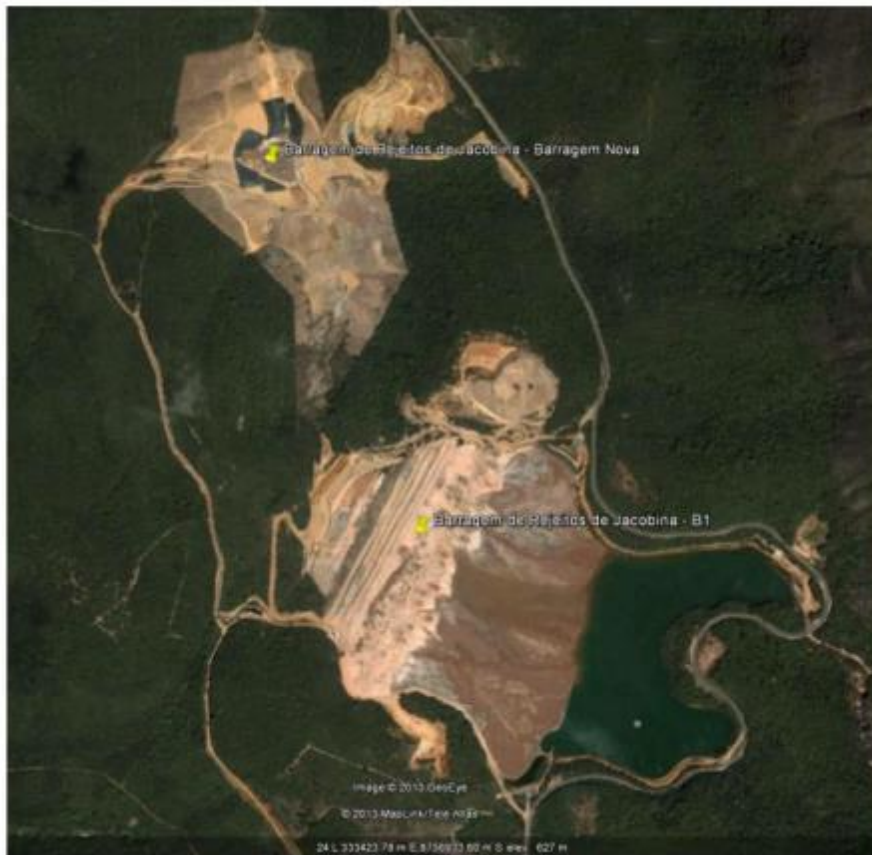
Figura 3-21 – Vista da barragem B1 e da barragem Nova (GOOGLE EARTH, 2008 apud SAMPAIO 2013).
