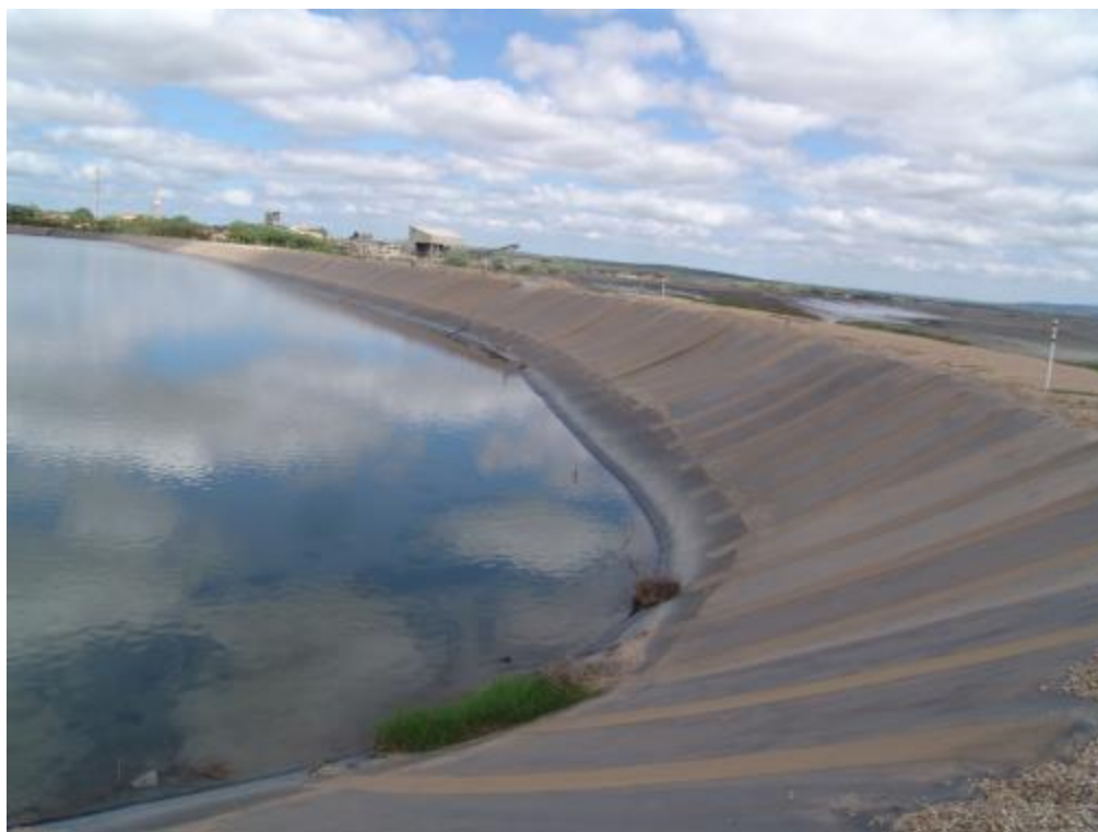
Figura 3-10 – Lago II – Vista do reservatório e espaldares revestidos com GM de PVC
