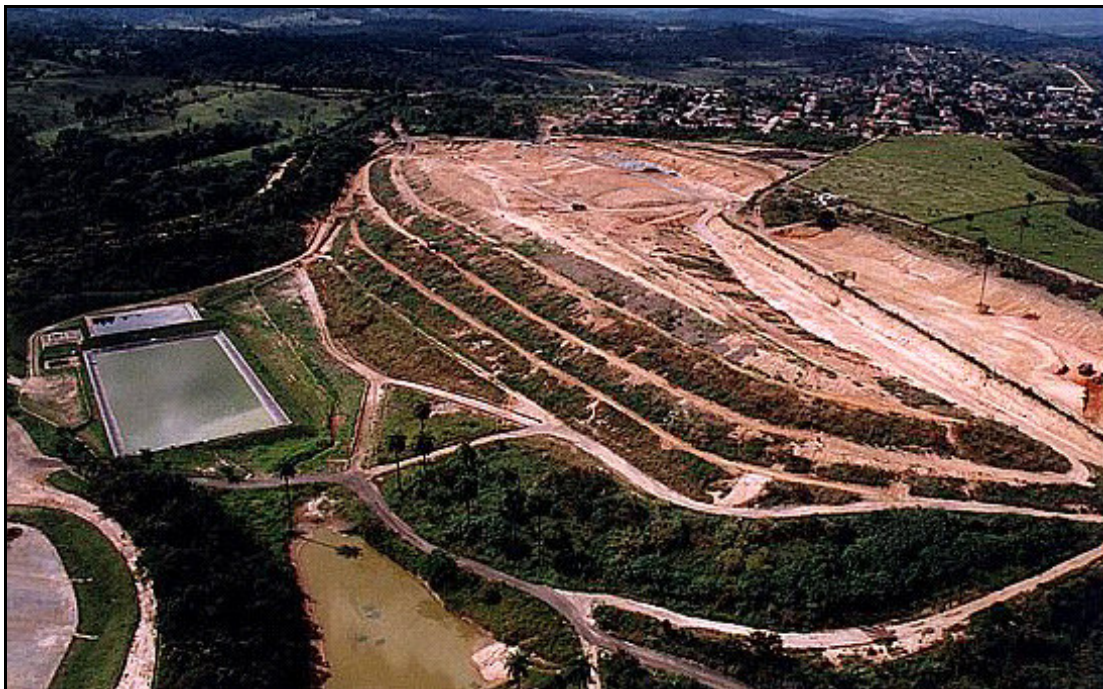
Figura 4.1 - Vista aérea do Aterro Sanitário de Betim
