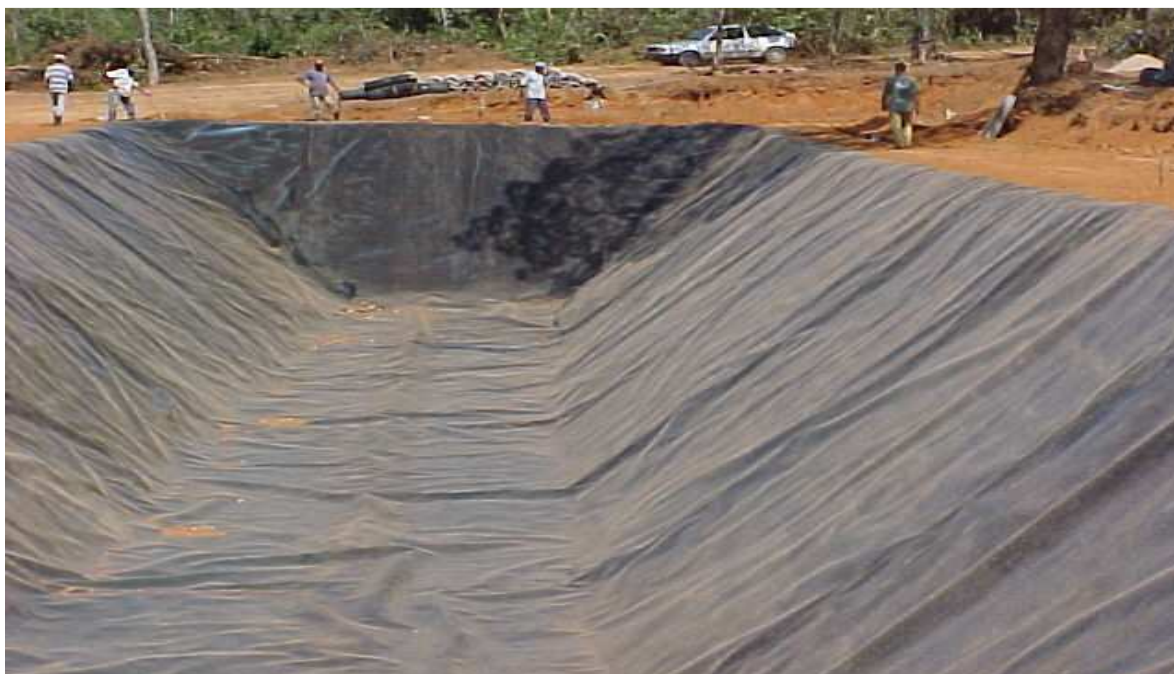
Figura 3-3: Aterro para resíduos não perigosos, em implantação
