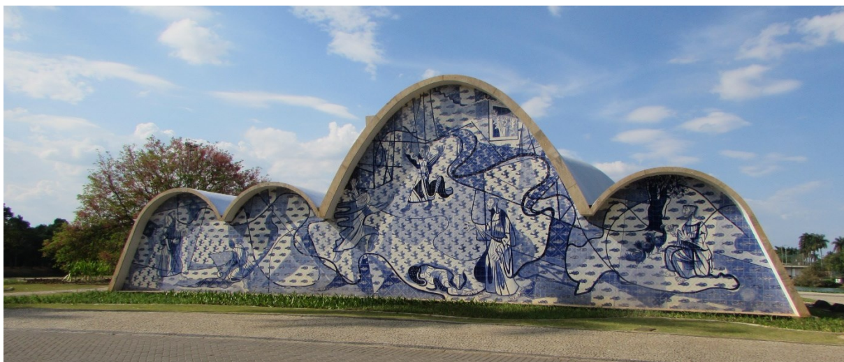
Figura 18 – Fachada posterior Igreja São Francisco de Assis – painel em azulejos de Cândido Portinari.
