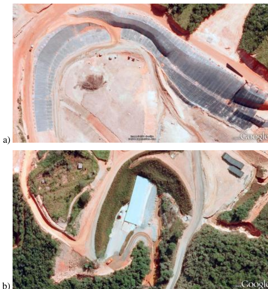
Figura 4.1 - Fotos aéreas do Aterro Sanitário de Macaúbas: a) células de aterramento e b) demais instalações do aterro sanitário. Fonte: Google Earth
