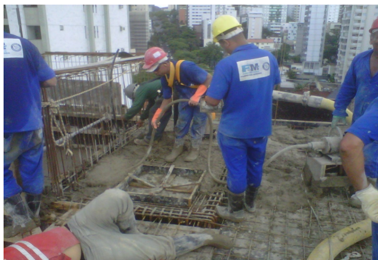
Foto 4.4: Vibrador para adensar CCV
