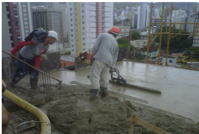
Foto 4.3: Régua vibratória de adensamento e regularização
