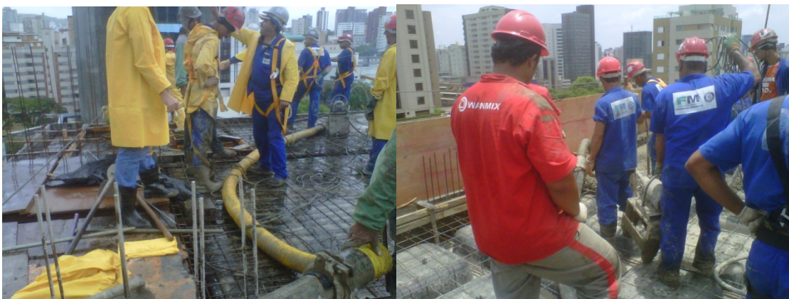
Foto 4.1: Espaço reduzido com um número de trabalhadores grande.
