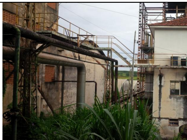
Foto 25: Visão parcial da ex-usina Ariadnópolis.
