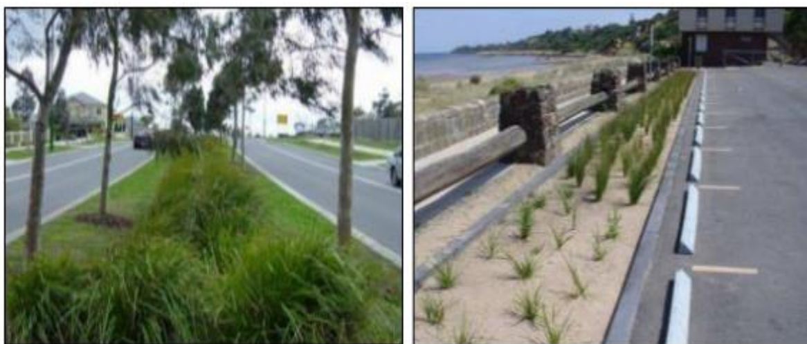
Figura 3.10 – Sistemas de biorretenção em vias e estacionamentos em Melbourne
