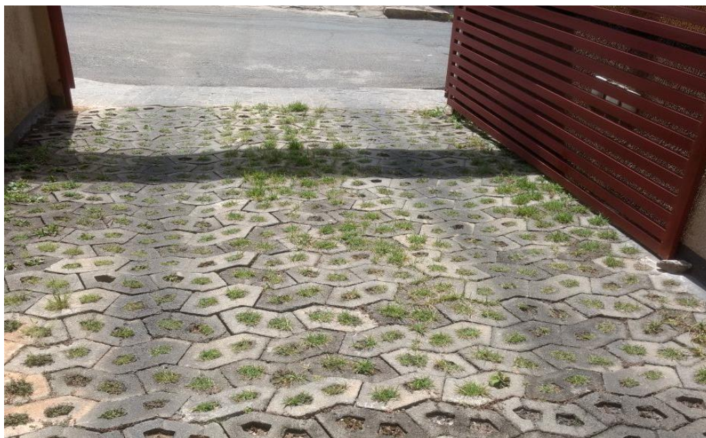
Figura 3.7 - Implantação de blocos de concreto vazado em garagem
