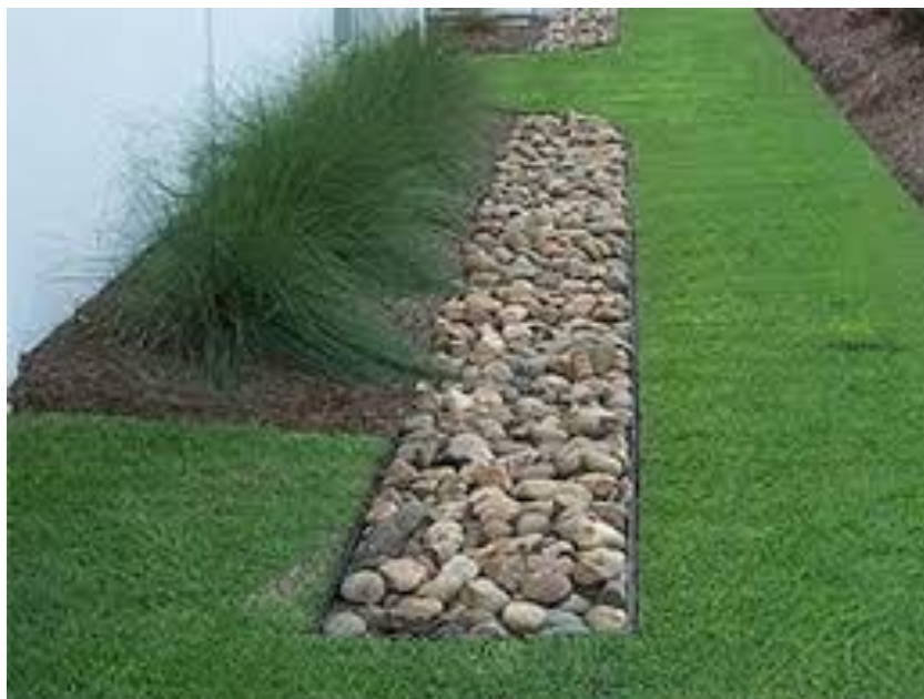
Figura 3.8 - Implantação de trincheira de infiltração
