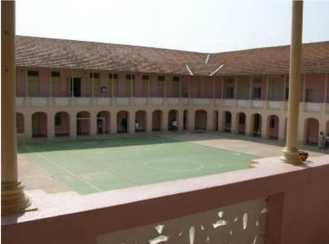
FOTO 4 – Vista do pátio interno do prédio original
