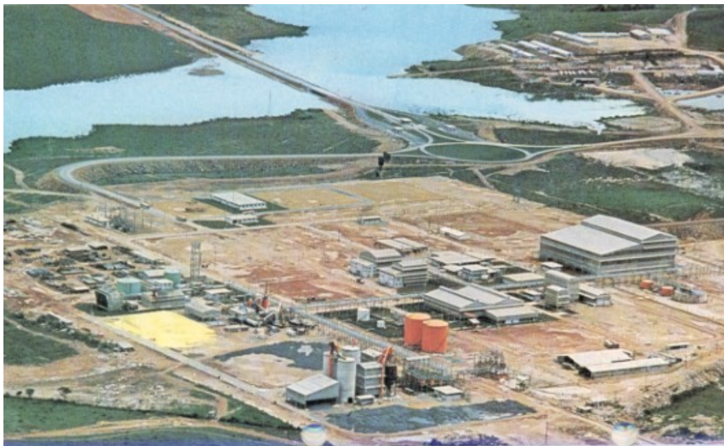
FIGURA 4.3 – Vista Parcial da Usina de Tratamento Químico, a Fábrica de Ácido Sulfúrico, o Conjunto de Instalações Auxiliares, a Unidade de Rejeitos Líquidos e Sólidos e a Usina de Produção de Concentrado de Urânio do Complexo Industrial da INB em Poços de Caldas, MG
