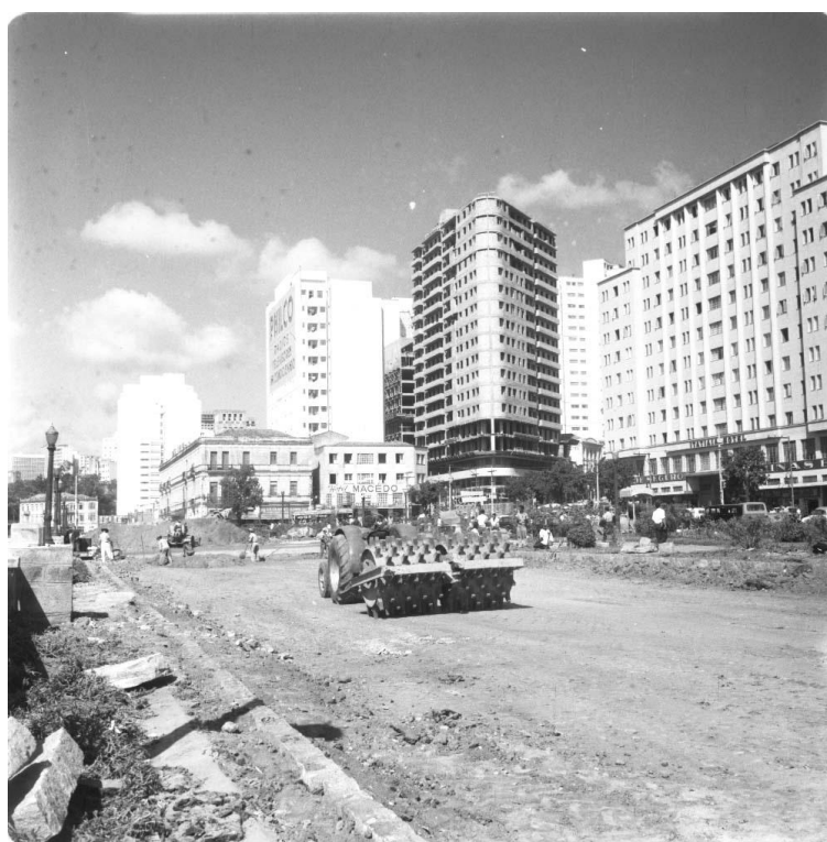
Figura 12 – Obras para a duplicação da Avenida dos Andradas (1963).
