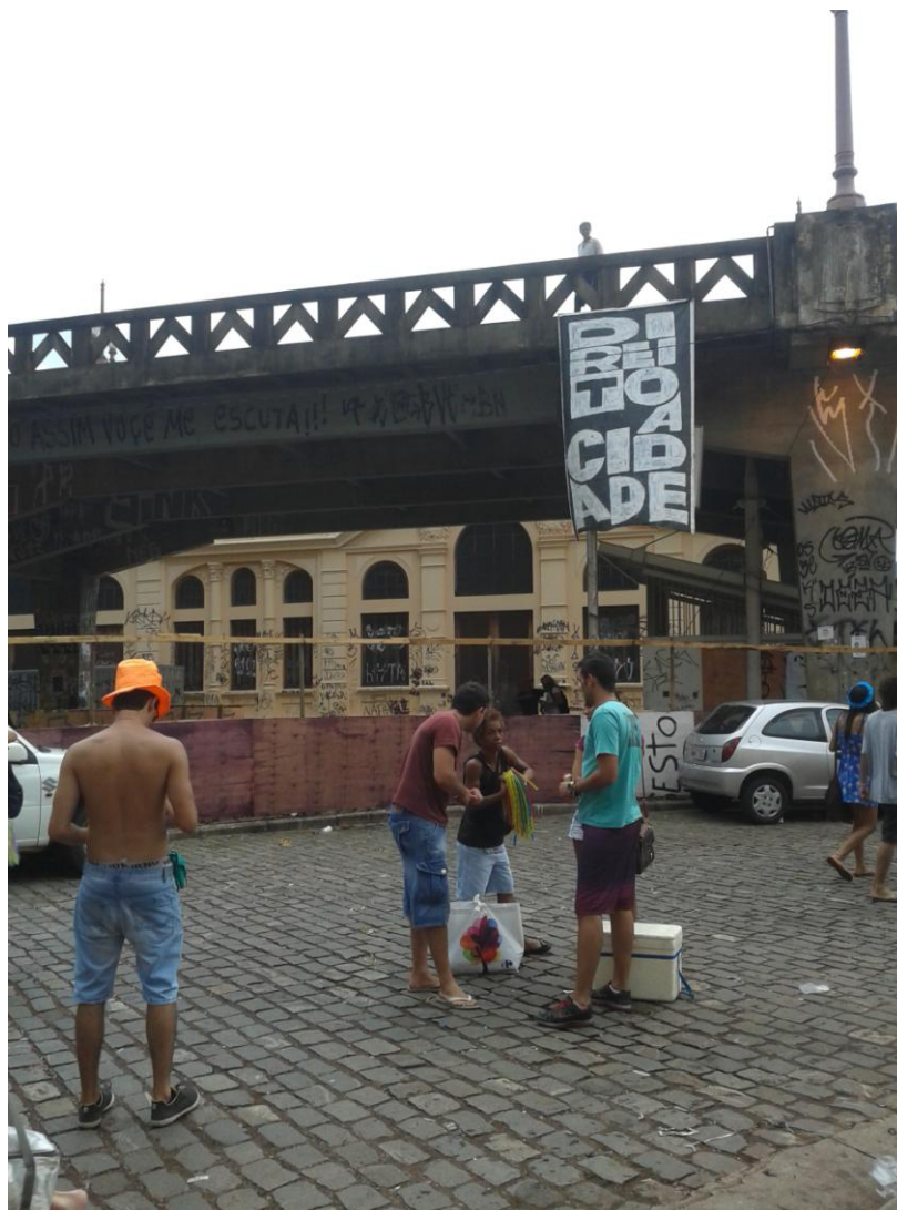
Figura 99 – Viaduto Santa Tereza [5] em 1º mar. 2014.
