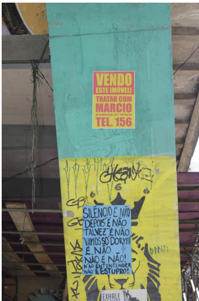
Figura 98 – Viaduto Santa Tereza [4] em 10 fev. 2014.
