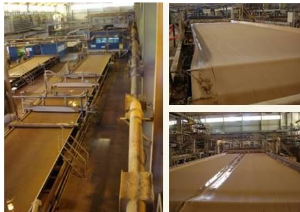
Figura 3.9 - Filtragem de rejeitos na mina de La Coipa (Chile). (19)
