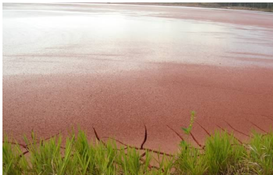
Figura 3.5 - Disposição convencional de rejeitos diluídos em barragens. (20)
