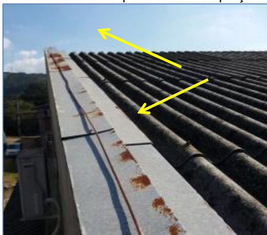
FIGURA 37 – Exemplo malha de captação
