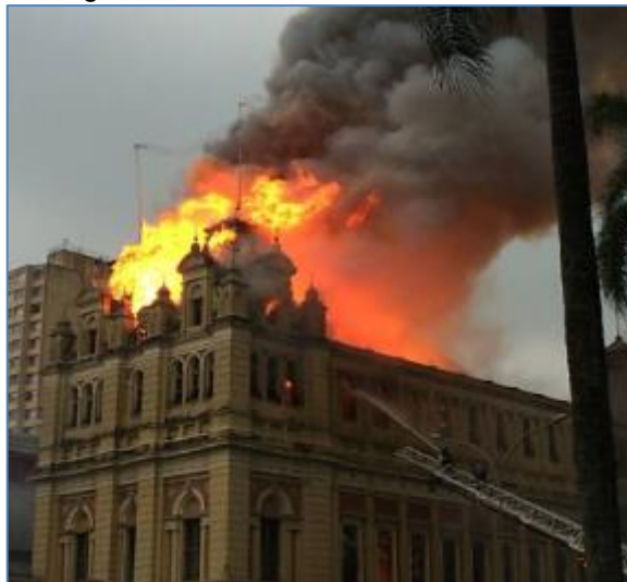
FIGURA 6 – Incêndio no Museu da Língua Portuguesa, 2015
