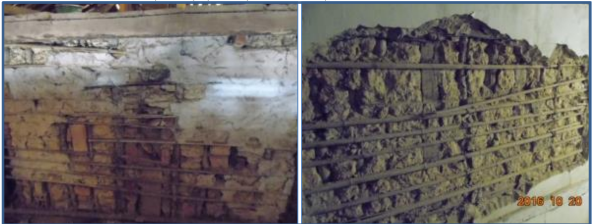
FIGURA 11 – Paredes de pau-a-pique no pavimento superior da Casa da Glória
