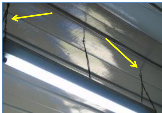
FIGURA 41 – Afastamento de reator com tetos combustíveis
