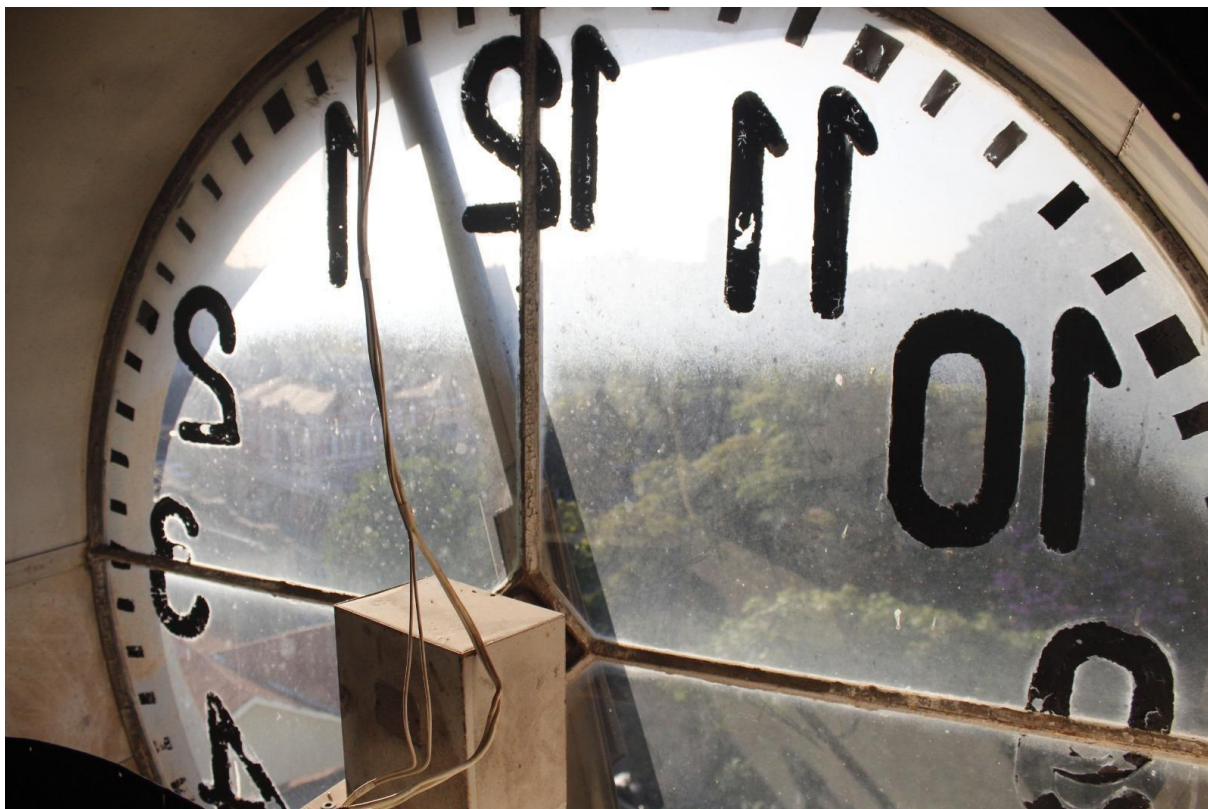
FIGURA 54 - Relógio da torre da Igreja de Santa Tereza
