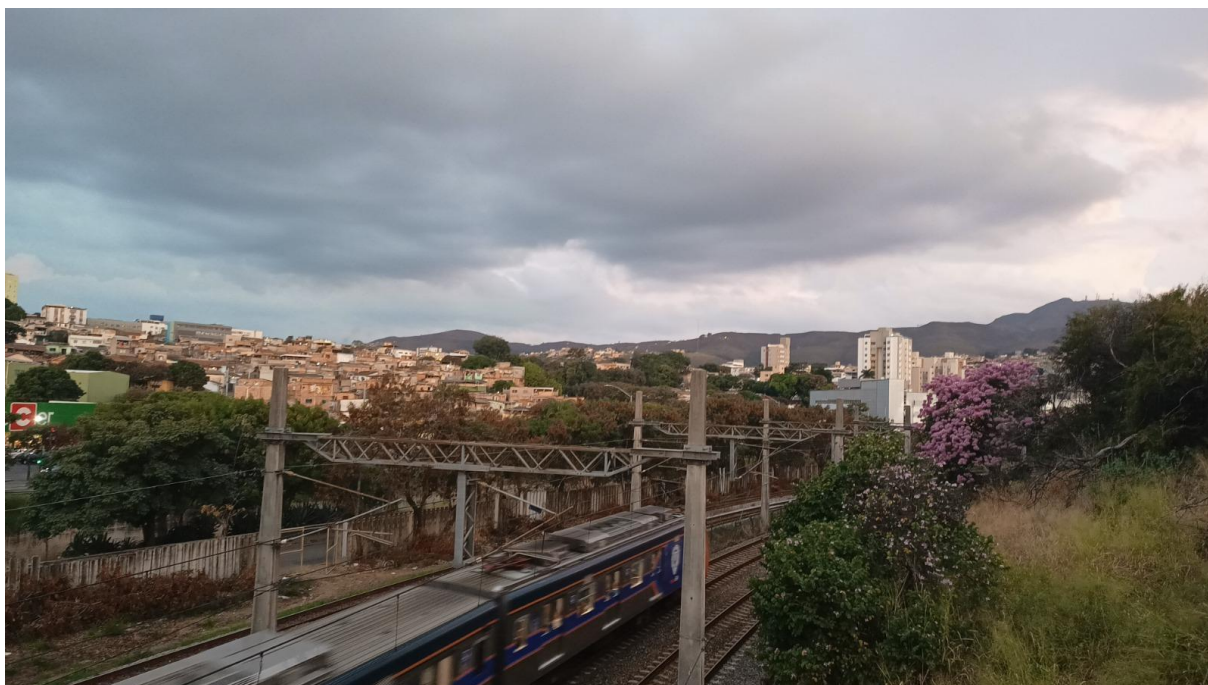
FIGURA 59 - Vista dos trilhos de trem e metrô sob passarela
