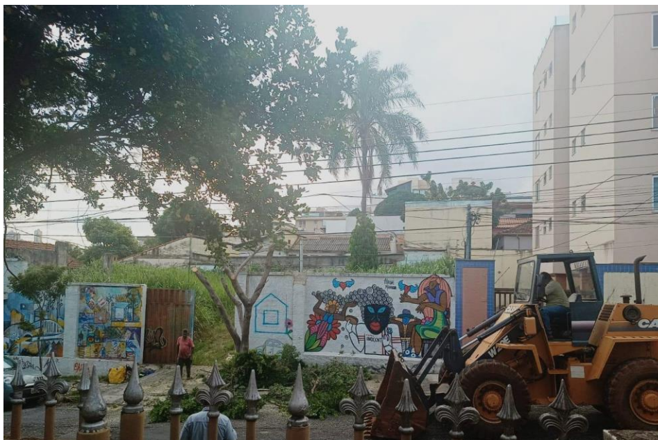
FIGURA 97 - Remoção de árvore para construção de prédio
