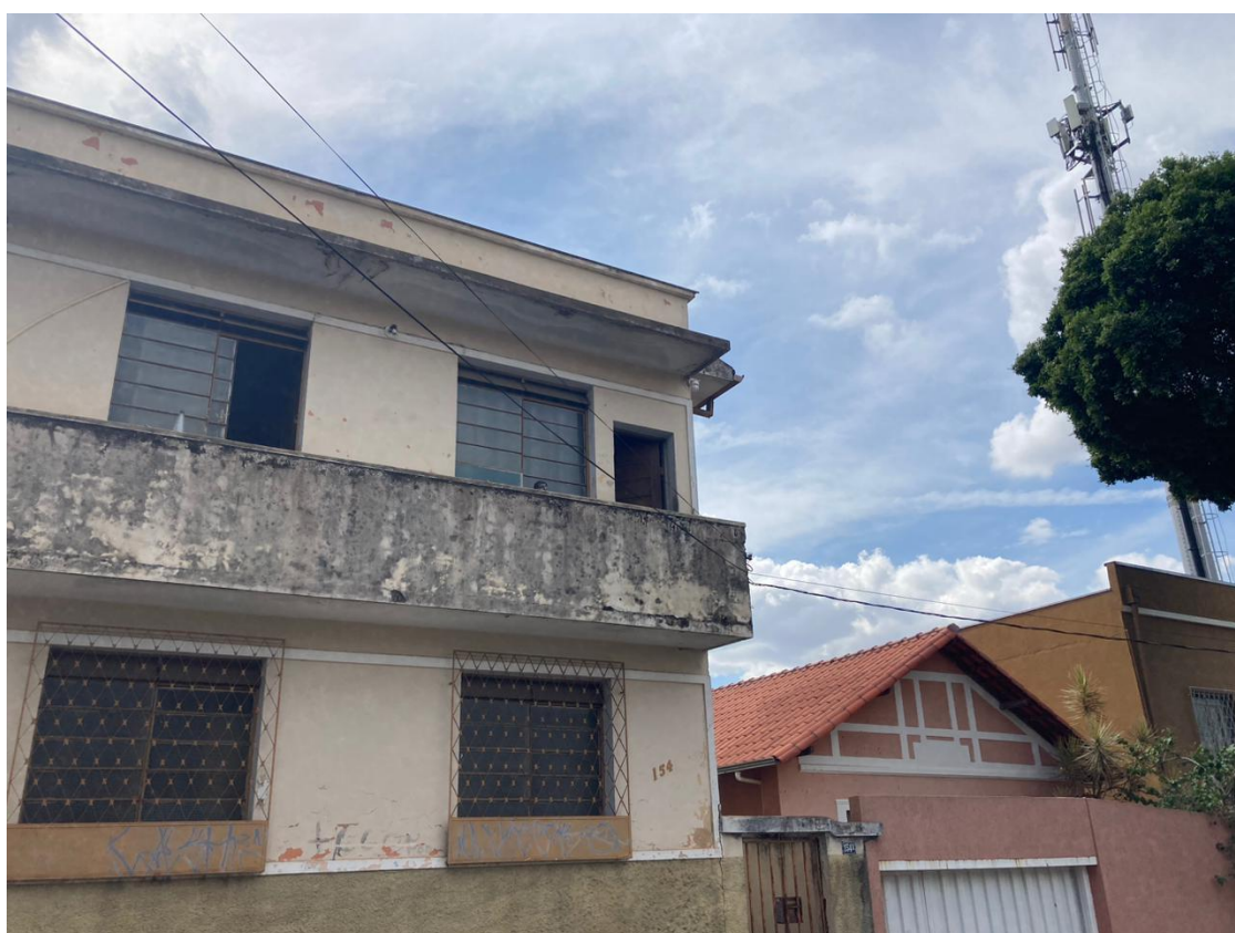
FIGURA 13 - Predinho ao lado de casa à rua Itacolomito
