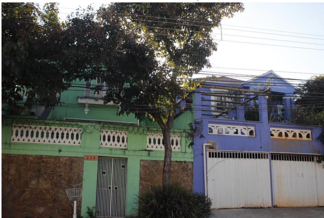
FIGURA 14 - Casas de varanda suspensa no bairro
