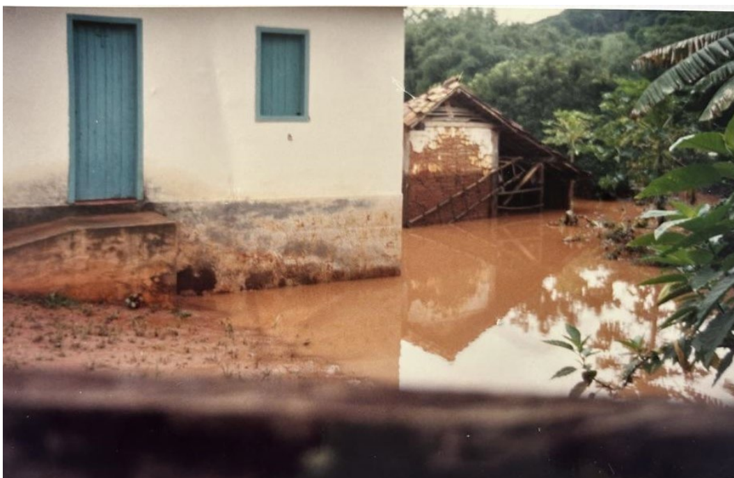
Figura 11. Fotografia da casa de GV durante uma enchente do Rio Paraopeba.
