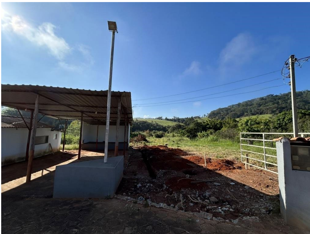
Figura 15. Fotografia da base da construção do posto de saúde.
