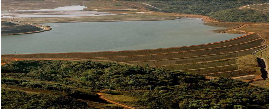
Figura 4.2 - Barragem de rejeitos, Brumadinho antes do rompimento
