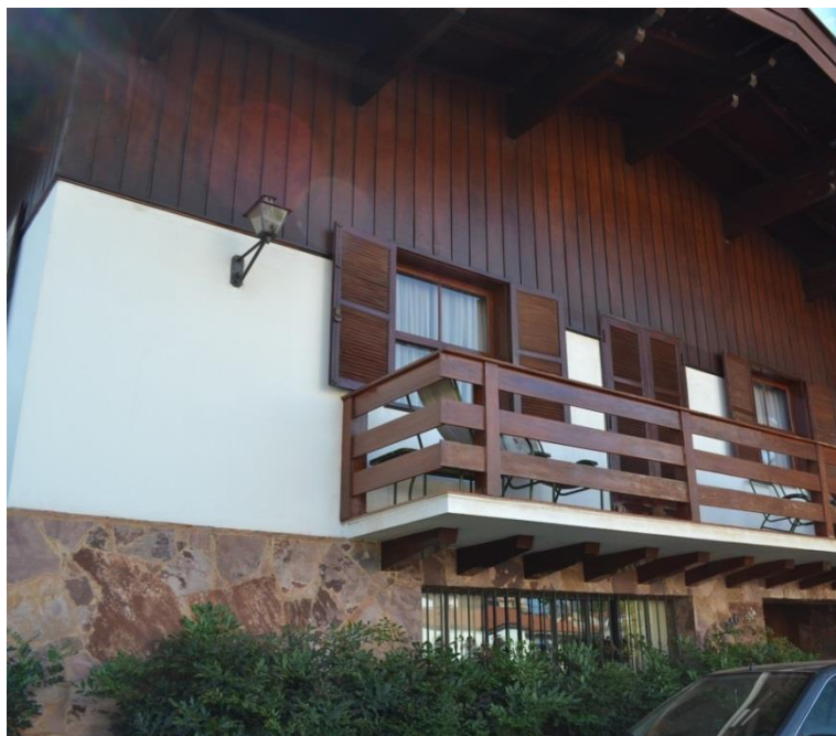
Detalhe da Fachada da Residência de Hugo Rodrigues da Cunha, 1959. Eitão em lambril de madeira, embasamento do edifício revestido de pedra e sacada apoiada em vigas em balanço, tipo mão francesa.
