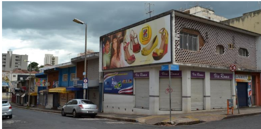
Conjunto Comercial Uberaba, sem data, visivelmente deteriorado e descaracterizado. Uberaba, MG.
