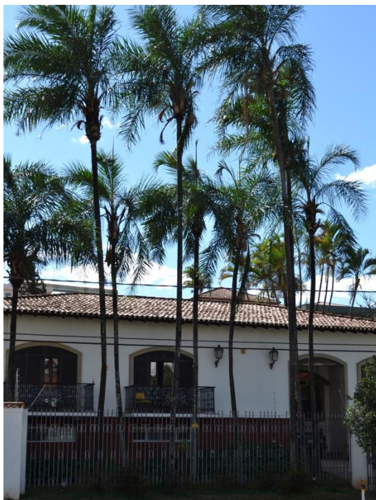
Fachada da Residência Marco Túlio Fontoura, 1971. Sacadas com guarda corpo de ferro, base do edifício revestido com pedra tapiocanga e aberturas com arco abaulado 8 marcado por moldura (arquivolta).
