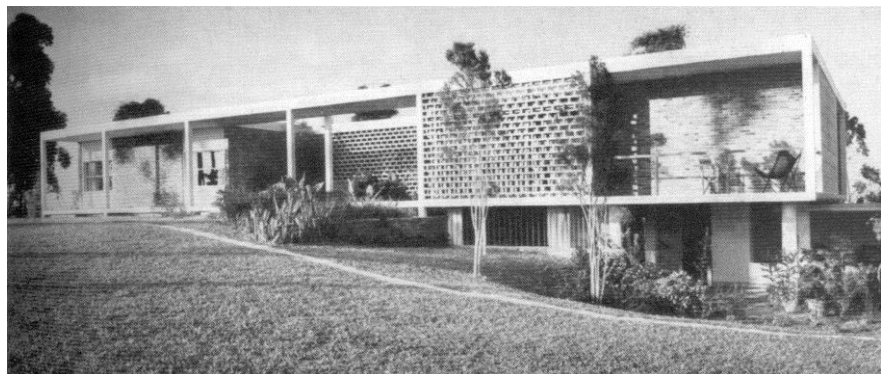
Fachada principal - segunda casa do arquiteto Oswaldo Bratke no Morumbi (1951)
