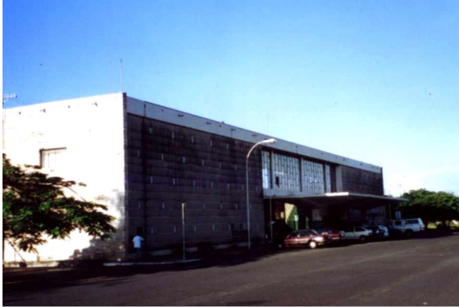
Terceiro edifício para a sede Estação da Mogiana, Uberaba/MG. Projeto de Oswaldo Bratke, 1961.
