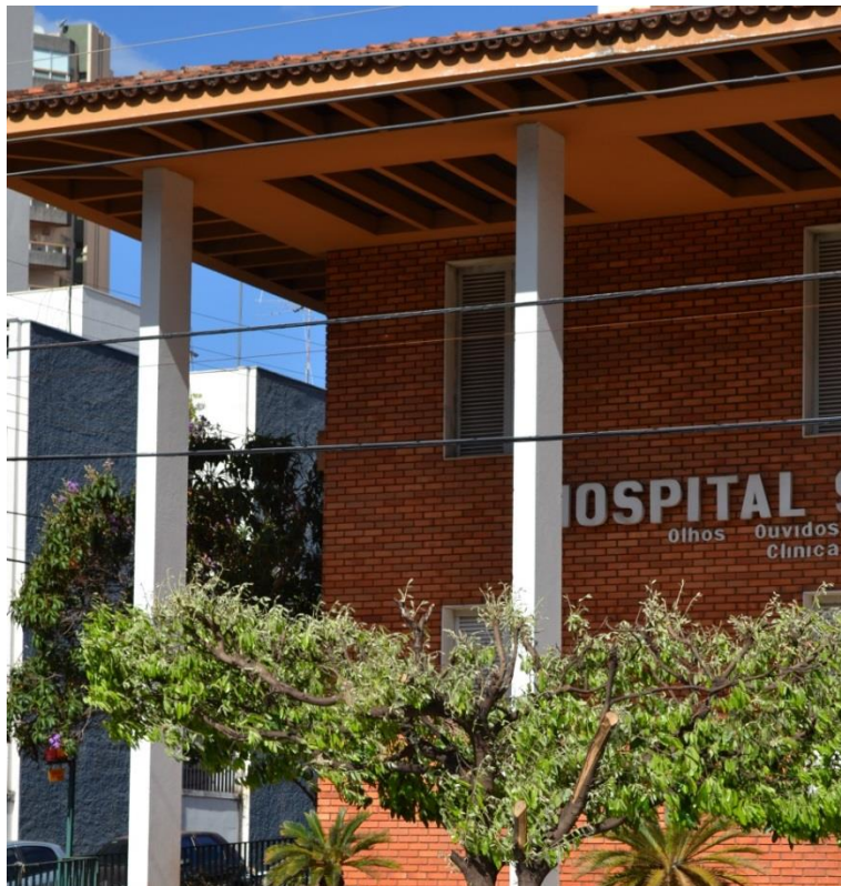
Fachada residência Aristides Riccioppo, hoje Hospital Santa Lúcia, com revestimento cerâmico e laje nervurada vazada de sentido único, 1966.
