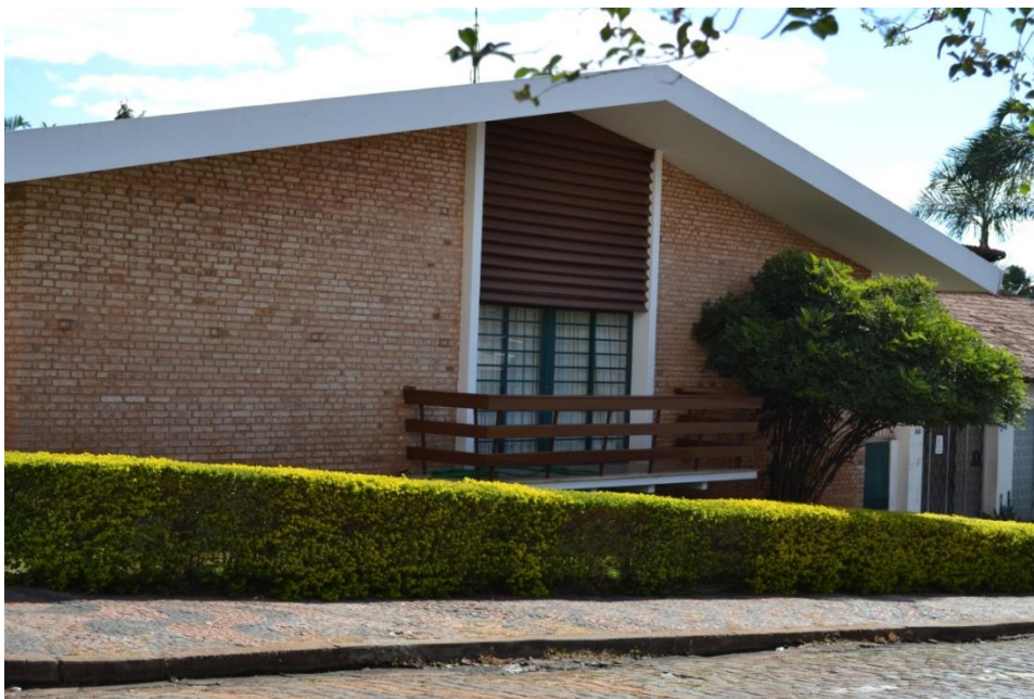
Fachada da Residência Francisca de Andrade Costa Carvalho, 1961. Detalhe em clapboard de madeira no eitão da casa, tijolinho a vista e beirais em laje de concreto.
