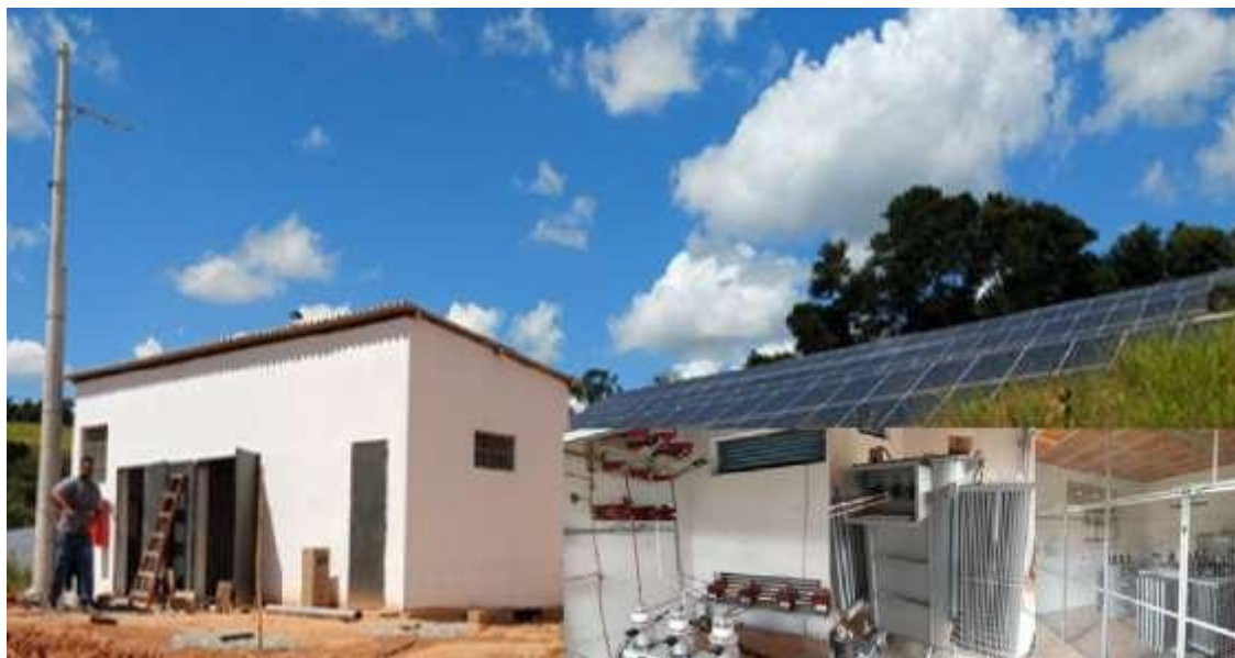
Figura 14 - Usina de Minigeração de Energia Solar Fotovoltaica
