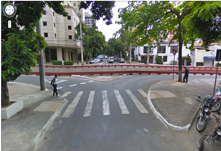
Figura 16 – Continuidade Rua Antônio de Albuquerque interrompida pela trincheira que liga a Rua Rio Grande do Norte à Avenida Nossa Senhora do Carmo, em Belo Horizonte.
