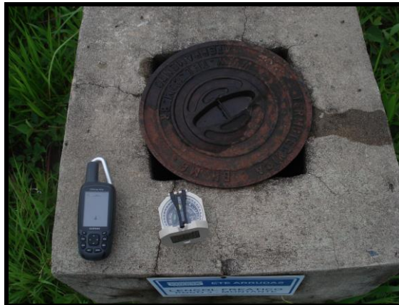
Fotos 14 – Vista do poço C03
