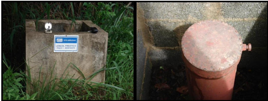
Fotos 10 e 11 – Vista do poço C01
