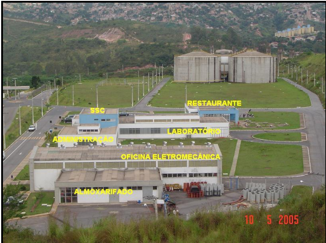
Foto 2 – Unidade de apoio operacional da ETE Arrudas
