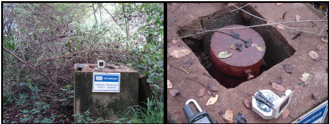
Fotos 15 e 16 – Vista do poço C04
