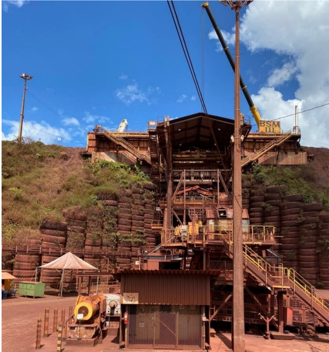
Figura 19: Britagem Semi Móvel
