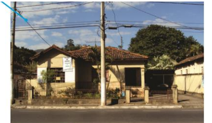
Vila Siderúrgica - vila dos engenheiros. Fonte: Autora, 2011.
