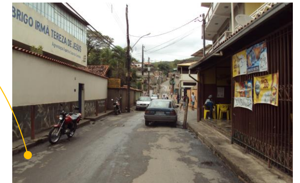
Rua Padre Nico, o principal acesso ao bairro Córrego da Ilha, com seus comércios e serviços combinados ao uso residencial. Fonte: Autora, 2012.
