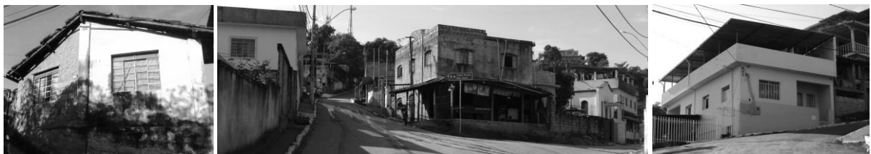
Imagens 48 a 50 - Alguns tipos edifícios existentes no bairro Morro da Cruz. Fonte: Autora, 2012.
