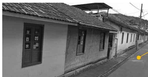
Tipo edifício residencial existente na Vila da Cruz, caracterizado pelos fechamentos em madeira – tabique.
