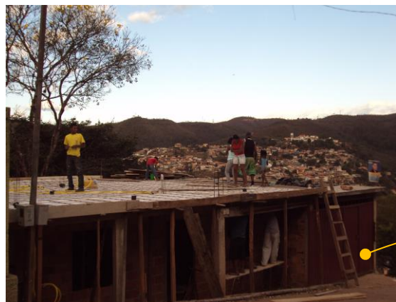
Um dos tipos edifícios recorrentes no bairro Cabral, em concreto armado e formando varandas no pavimento superior para socialização e contemplação da paisagem. Fonte: Autora, 2012.
