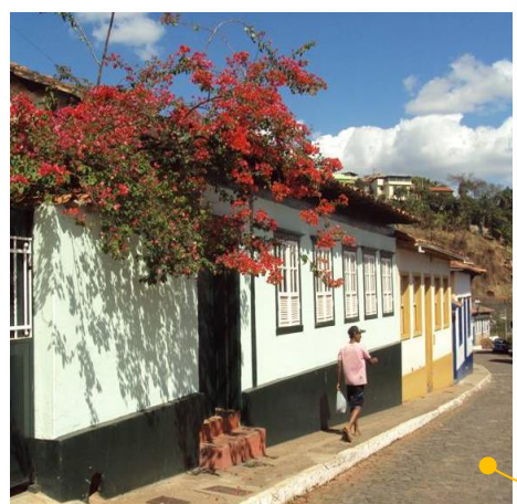
Vista da rua Dom Pedro II e parte de seu casario colonial preservado. Fonte: Autora, 2011.
