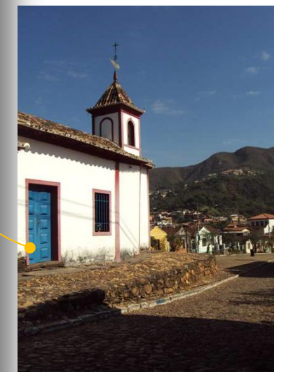
Igreja Nossa Senhora do Ó e a vista panorâmica a partir dela. Fonte: Autora, 2011.
