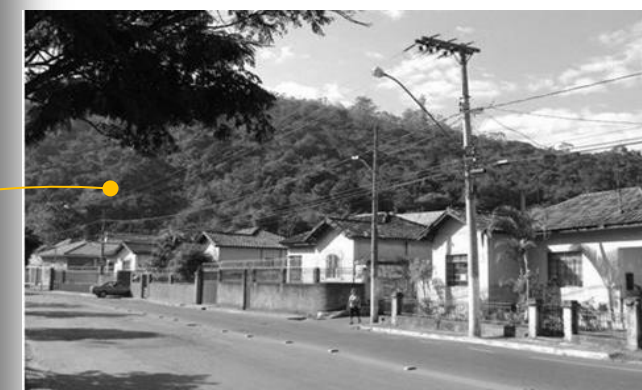
Rua da Usina, na Vila Siderúrgica, onde residiam os engenheiros da usina.
