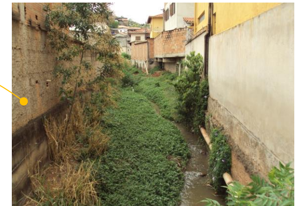
Situação atual do córrego da Ilha, cujo pequeno curso de água transpassa os vazios urbanos entre os lotes configurados. Fonte: Autora, 2012.
