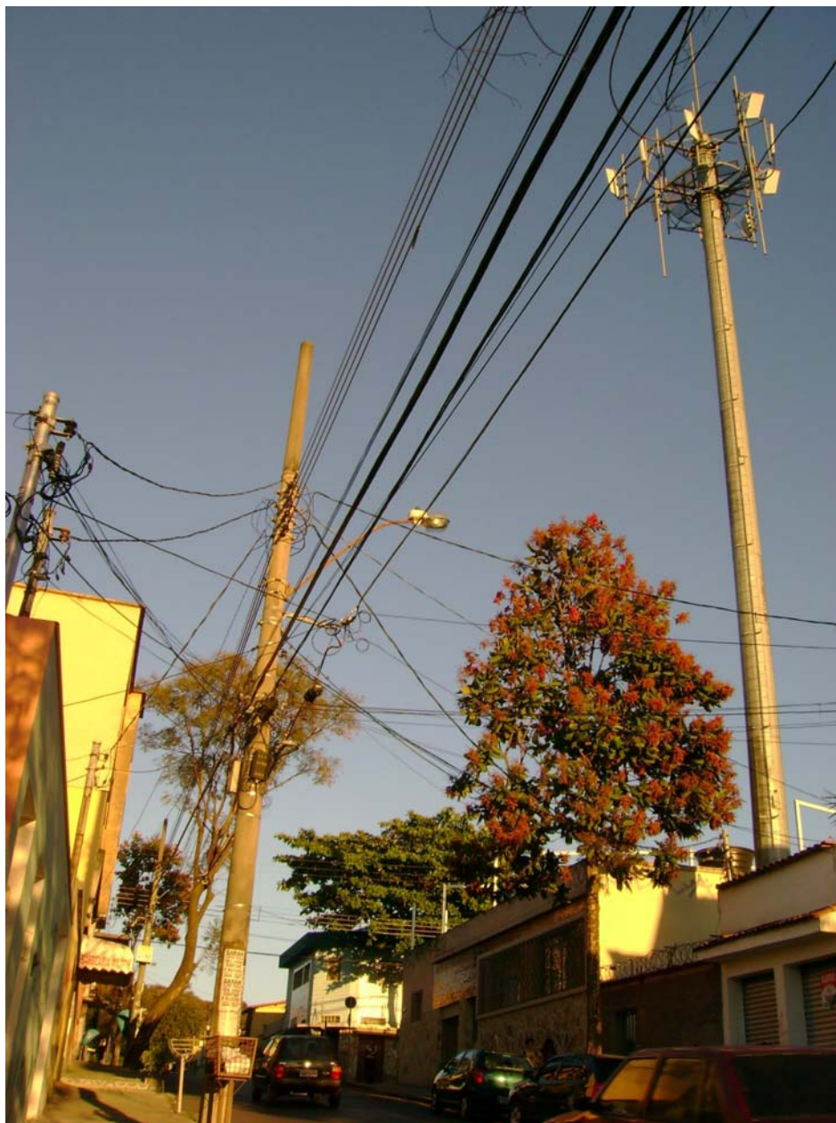
Figura 4.3: Fotografia de uma torre típica de telecomunicação instalada em área urbana próxima a consumidores residenciais.
