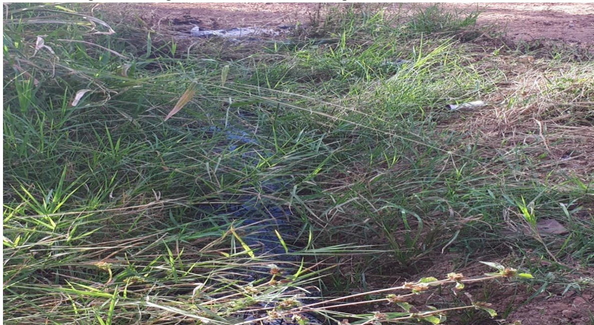
Figura 31 - Esgoto a céu aberto e invasão próxima à BR -153, Goiânia
