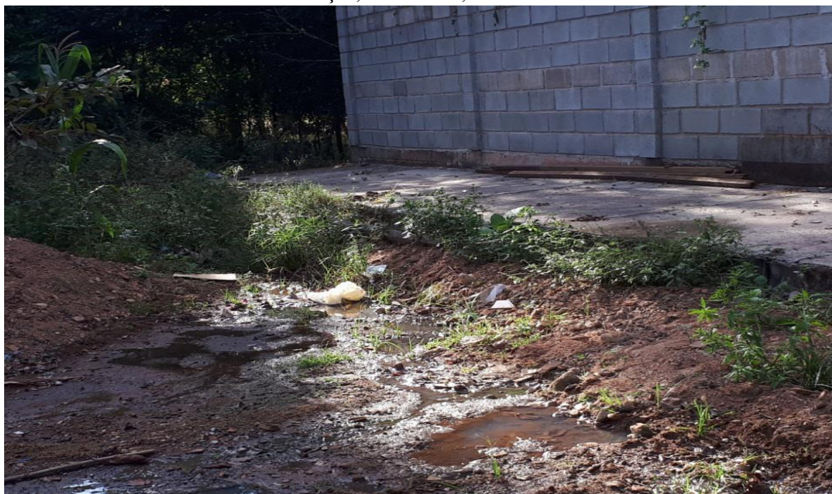
Figura 33 - Falta de asfalto, acumulação de lixo e esgoto próximo à invasão “Suvaco da Onça”, na BR 153, Goiânia
