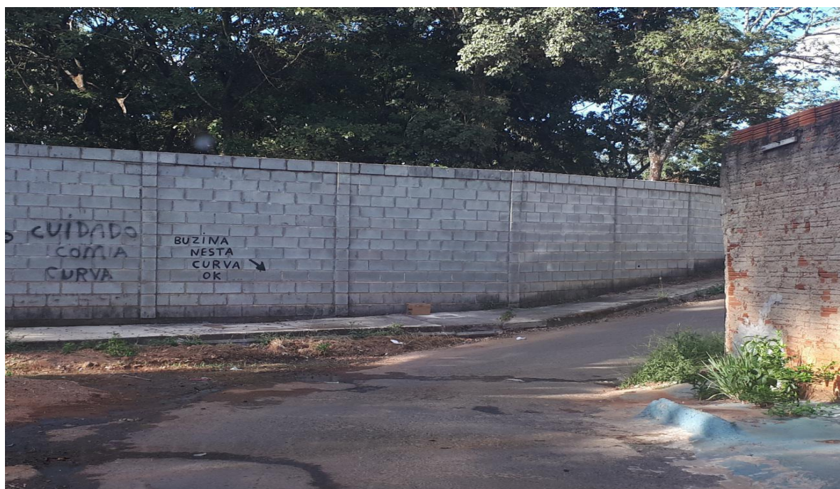
Figura 32 - Falta de sinalização próxima à invasão “Suvaco da Onça”, na BR- 153, Goiânia
