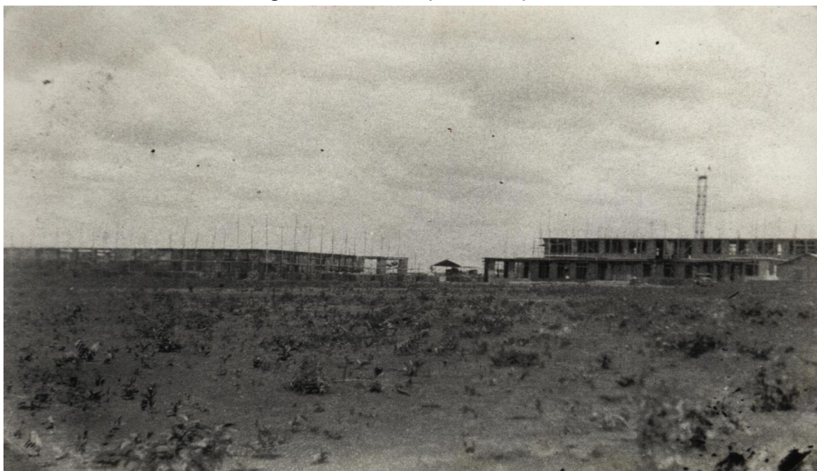
Figura 11 - Construção da Praça Cívica
