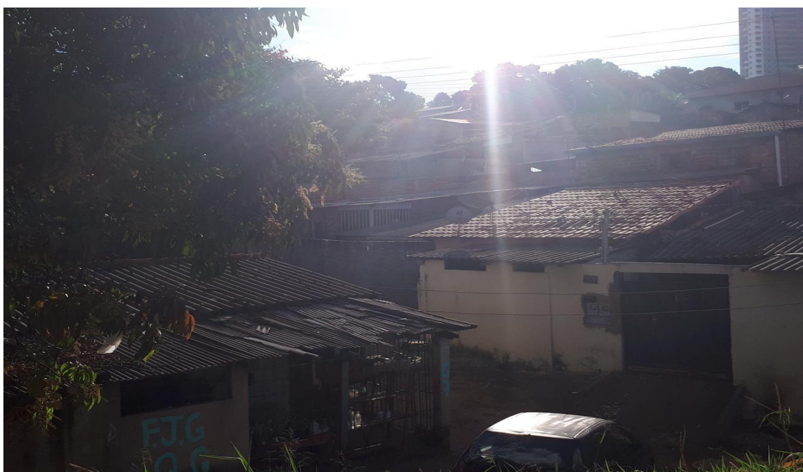
Figura 40 - Ocupações irregulares. Casas geminadas e precárias. BR-153, Setor Universitário Goiânia
