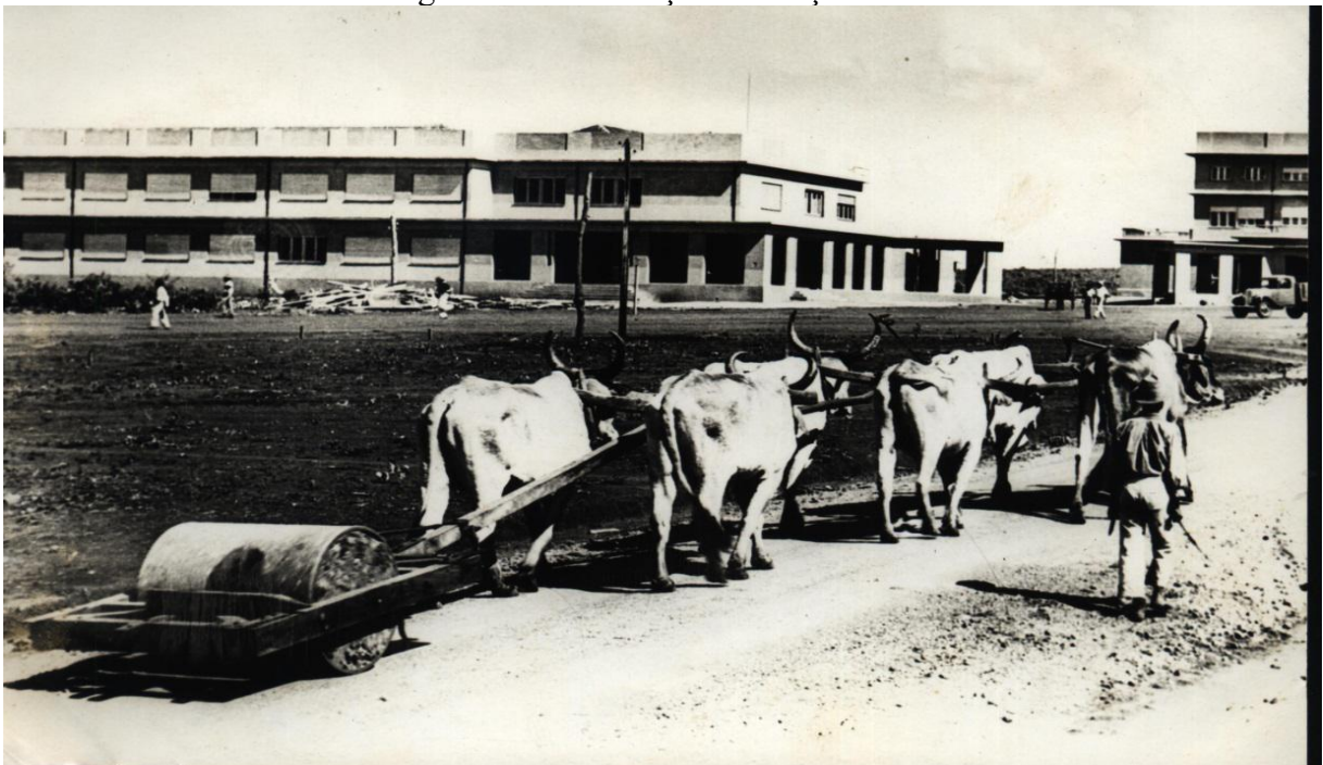
Figura 14 - Construção da Praça Cívica
