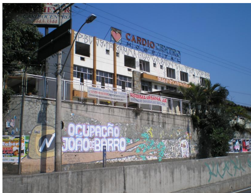
Figura 2 Visão da fachada do antigo hospital Cardio Centro que deu lugar a Ocupação João de Barro, na av. Antônio Carlos. Fonte: próprio autor
