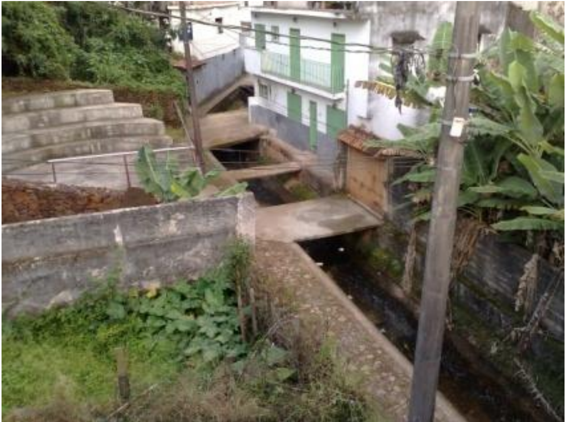
FIGURA 12 - Rua marginal e acessos a garagens Fonte: fotografia feita pela autora em 30 mai.2012
