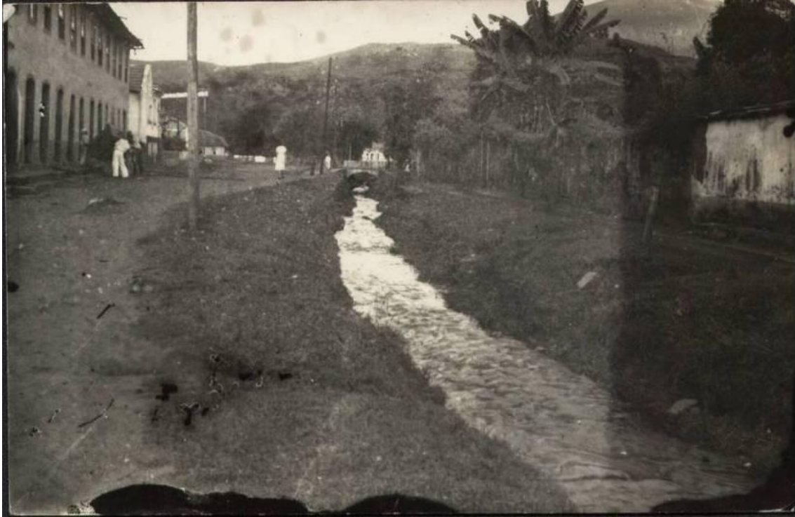
FIGURA 25 – Figura 6 da NP – Mariana. Canal paralelo ao Ribeirão do Carmo faz desaguar o Córrego Catete no Córrego do Seminário. A fotografia apresenta tentativa de saneamento de enchentes desde 1790, segundo Fonseca (1998). Fonte: NP – Mariana, Figura 06. Vol. 2/3. 2008, p.15.
