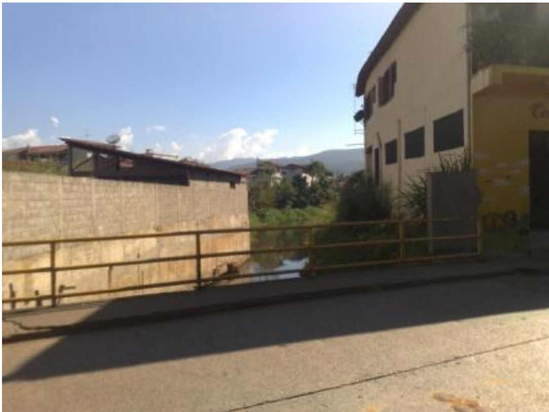
FIGURA 19 - Foz com edificações em “barragens”, termo utilizado pela população ao referir-se a arrimos de contenção das margens Fonte: fotografia da autora, 31 mai. 2012
