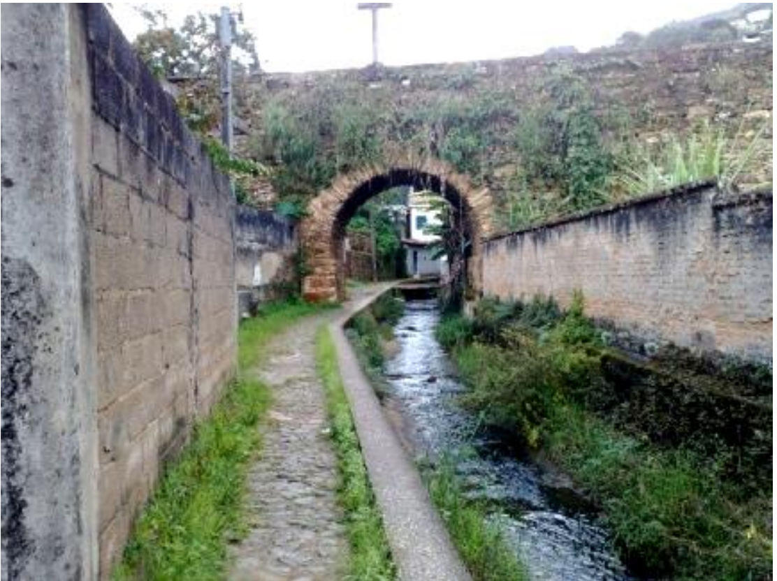
FIGURA 13 - Ponte do Palácio Velho Fonte: fotografia feita pela autora em 30 mai.2012
