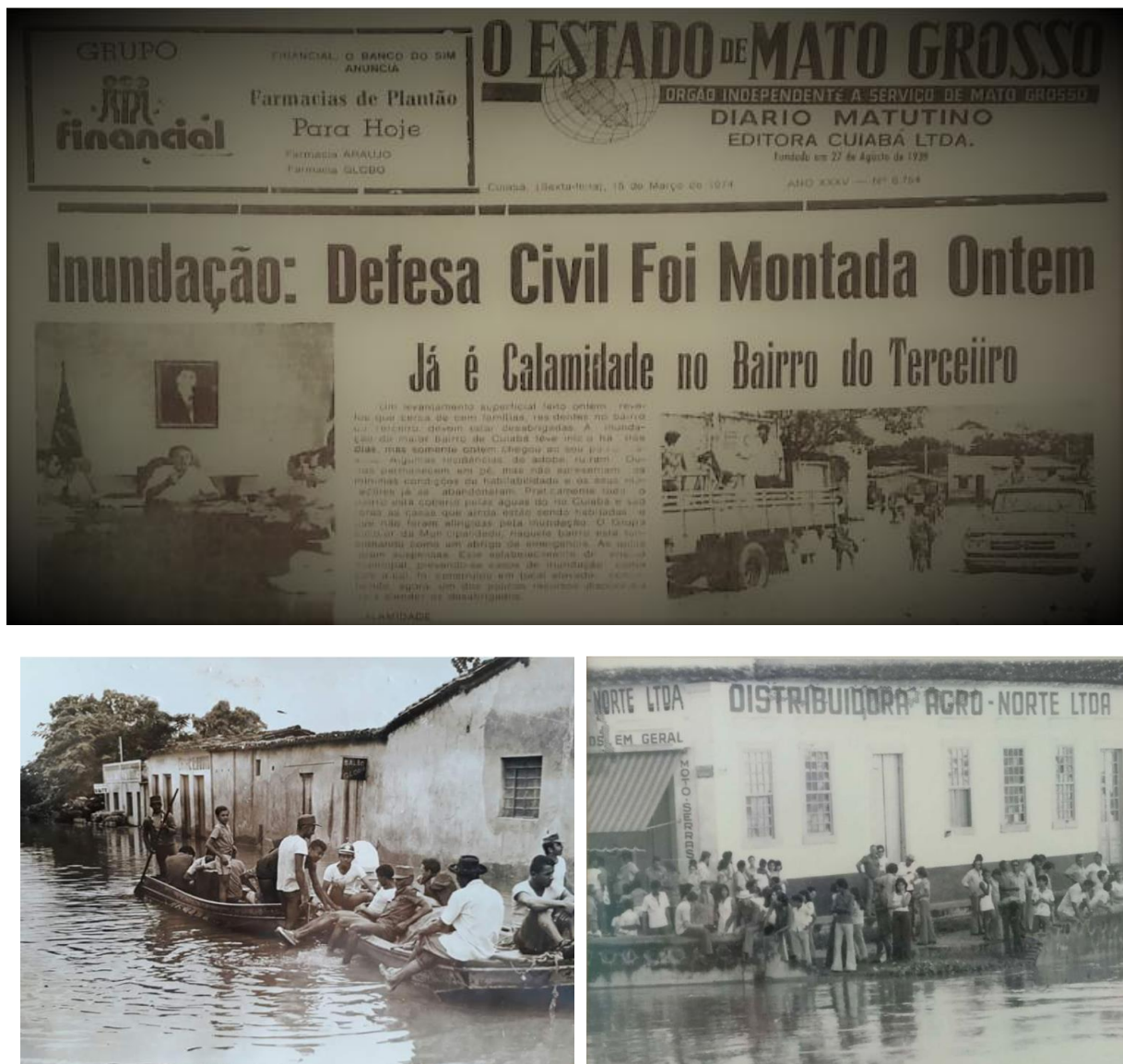
Figura 4.9 - Registros referentes à inundação ocorrida no município de Cuiabá em 1974
