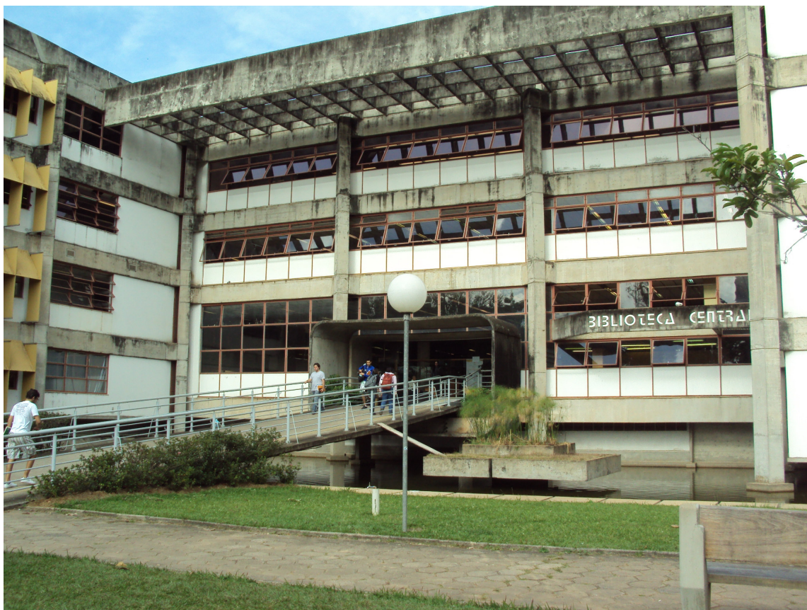
Figura 1 – Foto do Prédio da Biblioteca
