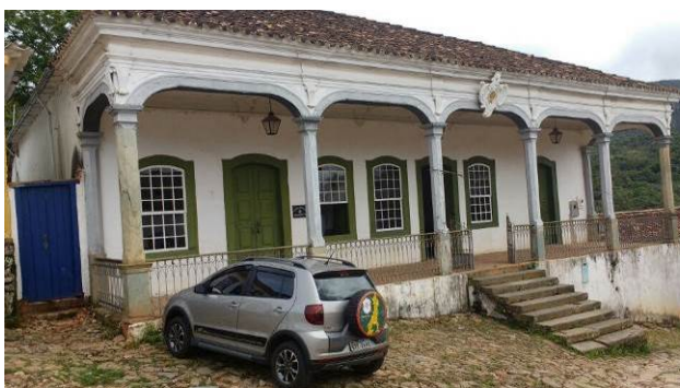
FIGURA 34: Antiga Casa da Câmara, atual Câmara Municipal de Tiradentes.
