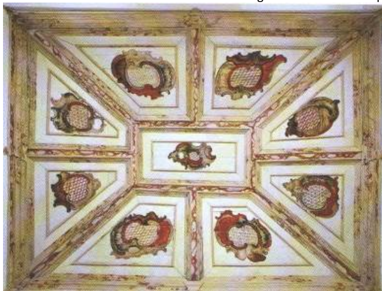
FIGURA 41: Ambiente interno do MCPT – forro em gamela da Sala dos Espelhos.
