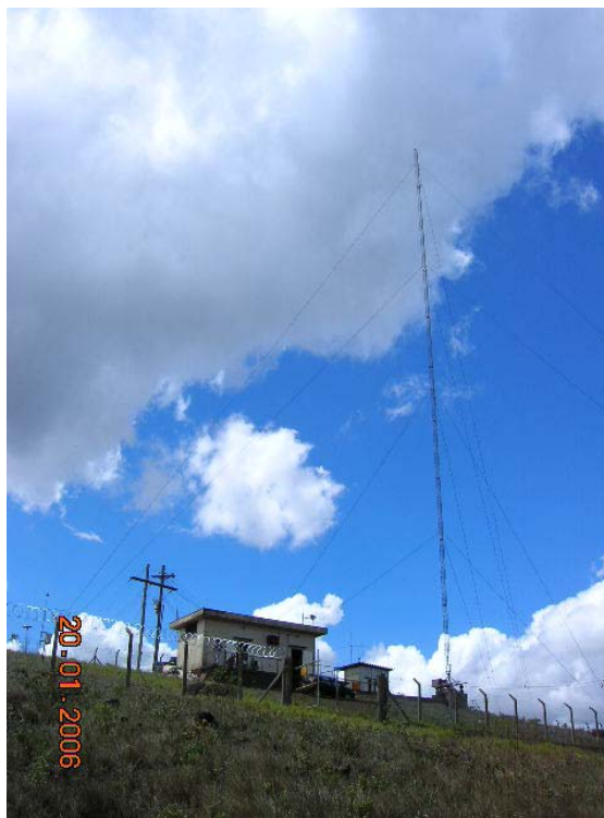
Figura 3.2 – Vista da torre e do abrigo da estação.
